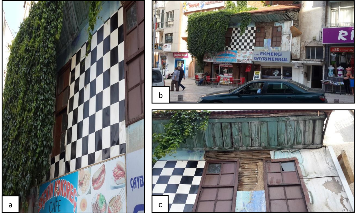
Şekil 3.8a, b, c 1484 ada 3 parseldeki yapının fotoğrafları (Kişisel Arşiv, 2016).
