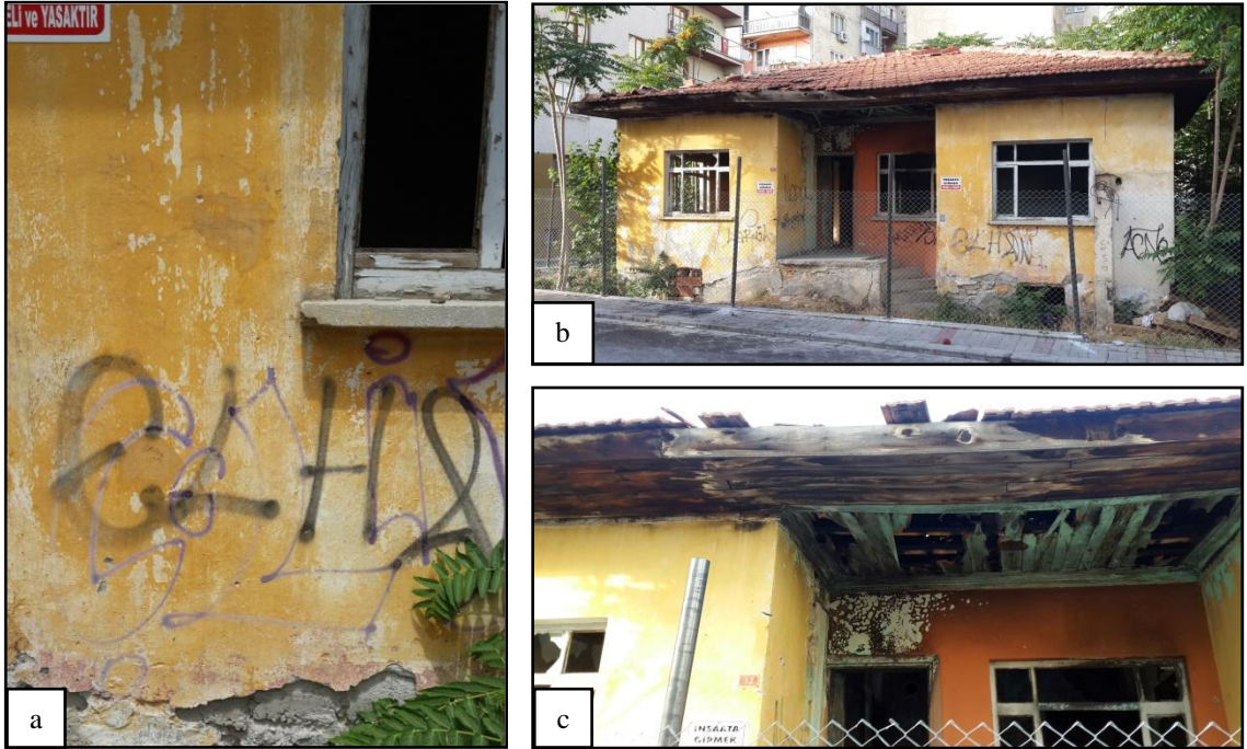
Şekil 3.6a, b, c, 432 ada 11 parseldeki yapının fotoğrafları (Kişisel Arşiv, 2016).
