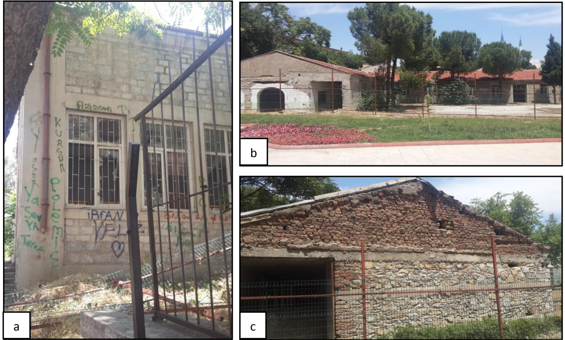
3.16a, b, c 7455 ada 2-7-8 parsellerdeki yapının fotoğrafları (Kişisel Arşiv, 2016).
