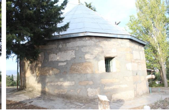
Foto. 36: Habib Acem Türbesi, Güneybatı Cephesi
