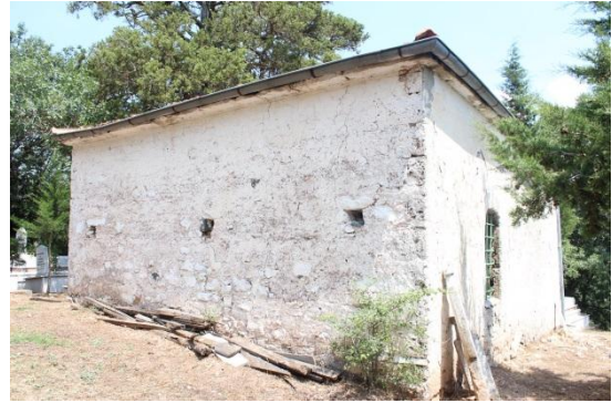
Foto. 197: Dediği Yaser Ali Sultan Türbesi, Güneybatı Cephesi
