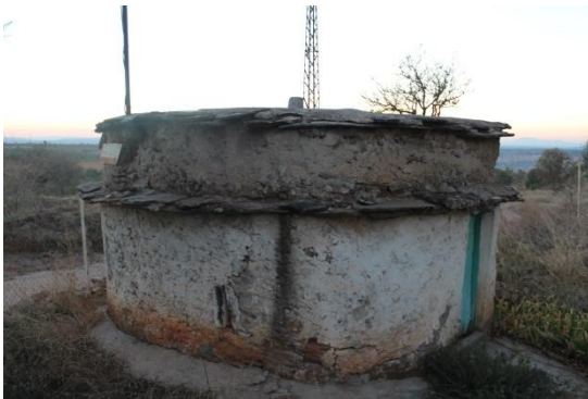
Foto. 53: Çat Dede Sultan Türbesi, Güneydoğu Cephesi
