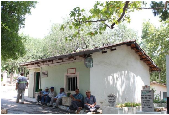
Foto.213: Ali Kâhya Efendi Türbesi, Güneydoğu Cephesi
