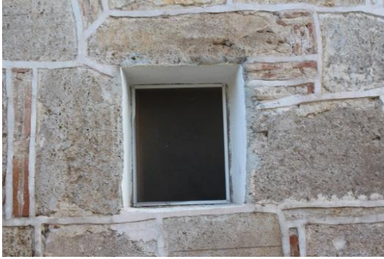
Foto. 46: Dedeköy Cami Türbesi, Batı Cephe
