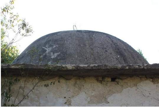
Foto.250: Teslim Abdal Sultan Türbesi, Kubbeden Görünüm
