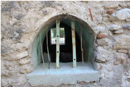
Foto. 147: Aşağı Cami Türbesi, Doğu Cephe Penceresi
