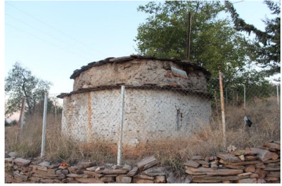
Foto. 50: Çat Dede Sultan Türbesi, Batı Cephesi
