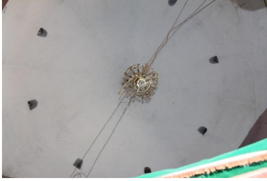
Foto.225: Ömer Gazi Türbesi, Kubbeden Görünüm
