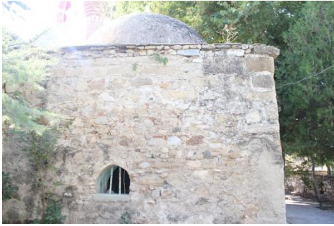
Foto. 145: Aşağı Cami Türbesi, Doğu Cephesi
