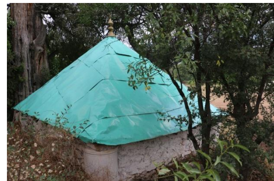
Foto.258: Aşağı Tekke Dede Türbesi, Kuzey Cephesi
