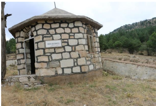
Foto.282: Dedeler Dedesi Türbesi, Güneybatı Cephesi
