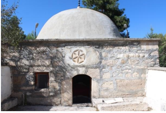
Foto. 11: Mahmud Gazi Türbesi, Ön Cephe
