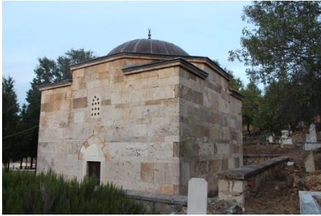
Foto. 94: Hüsameddin Bey Türbesi, Güneybatı Cephesi
