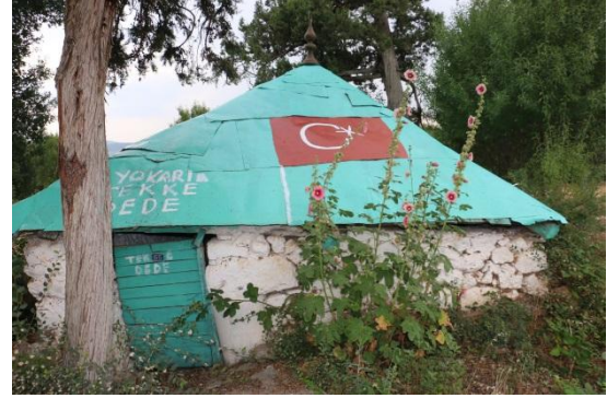
Foto.264: Yukarı Tekke Dede Türbesi, Doğu Cepheden Görünüm
