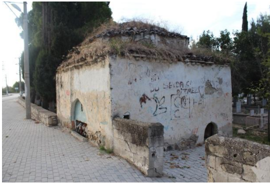
Foto. 73: Anonim Türbe I, Genel Görünüm
