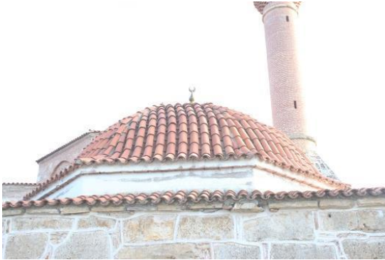
Foto. 48: Dedeköy Cami Türbesi, Kubbesi
