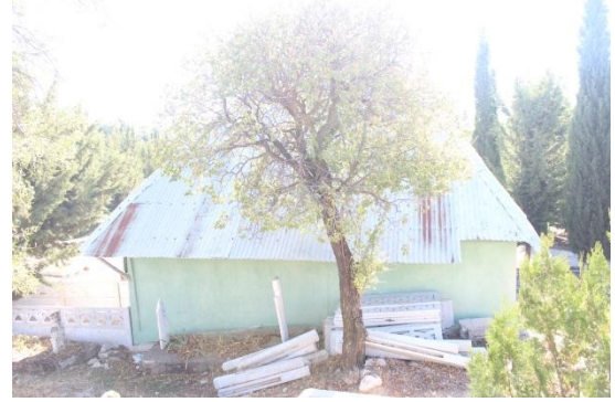
Foto. 23: Yatağan Baba Türbesi, Kuzey Cephesi
