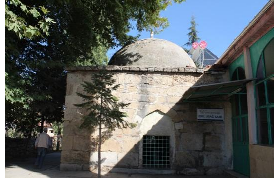
Foto. 144: Aşağı Cami Türbesi, Batı Cephesi
