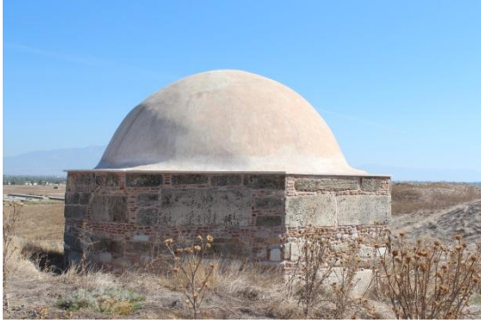
Foto. 60: Beyce Sultan Türbesi, Güneybatı Cephesi
