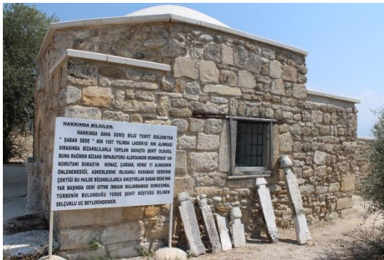
Foto. 135: Şaban Dede Türbesi, Batı Cephesi
