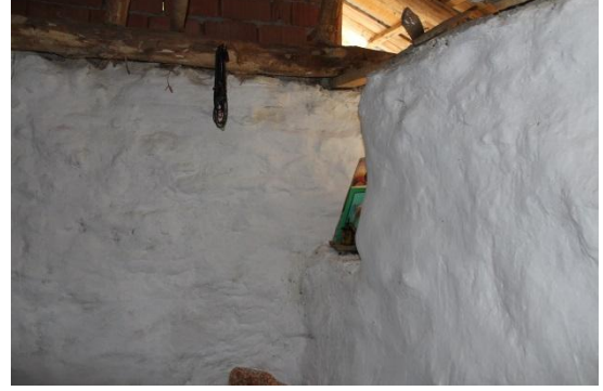
Foto. 295: Okçu Halil Türbesi, İç mekân Duvarlarından Görünüm
