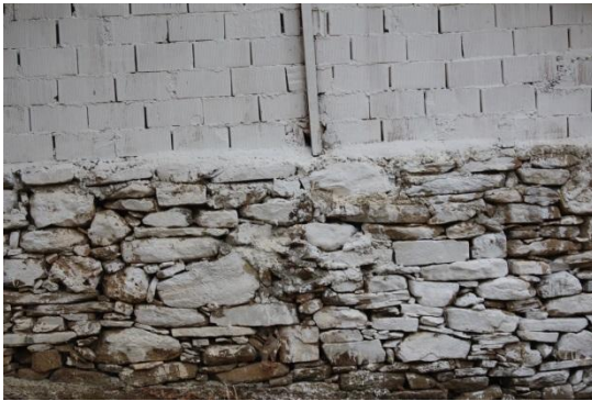
Foto. 292: Okçu Halil Türbesi, Doğu Cephesi Detay
