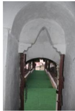
Foto. 108: Hüsameddin Bey Türbesi, İç mekândan Kapı Detayı
