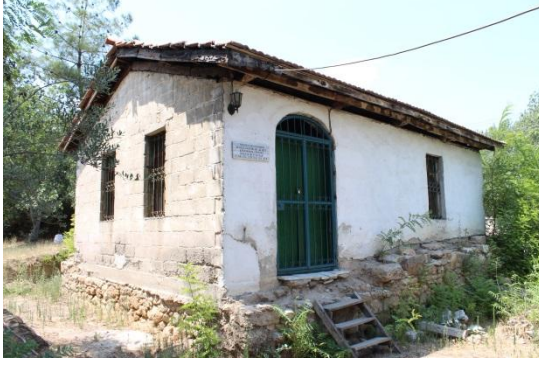
Foto. 66: Yediler Türbesi, Güneydoğu Cephesi
