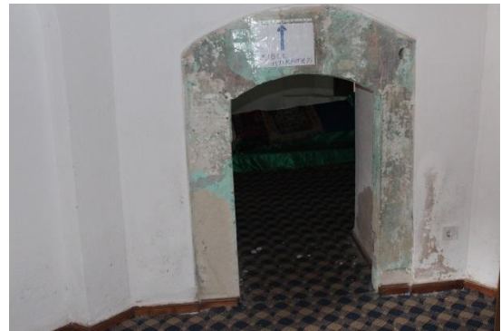
Foto. 123: Sultan Sarı Baba Türbesi, Ana mekan
