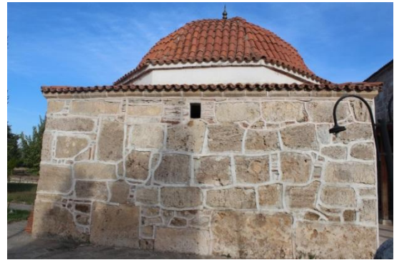
Foto.43: Dedeky Cami Trbesi, Batı Cephe
