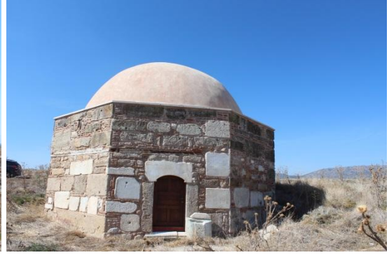
Foto. 61: Beyce Sultan Türbesi, Kuzeydoğu Cephesi
