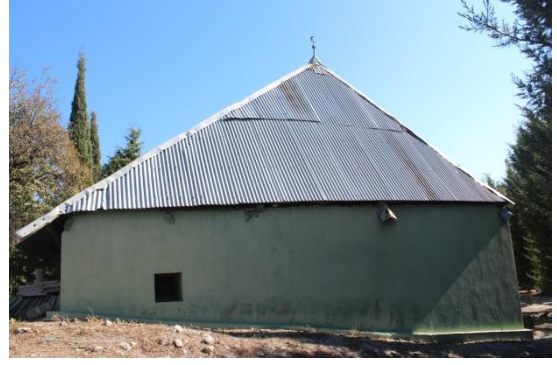
Foto. 21: Yatağan Baba Türbesi, Batı Cephesi
