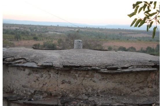
Foto.54: Çat Dede Sultan Türbesi'nden Üst Örtü Detayı
