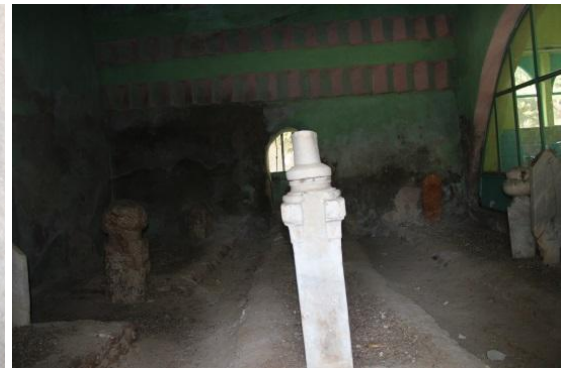
Foto. 152: Aşağı Cami Türbesi, İç mekândan Detay
