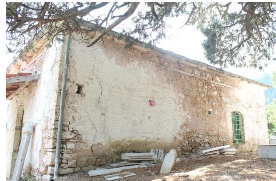
Foto. 199: Dediği Yaser Ali Sultan Türbesi, Kuzey Cephesi
