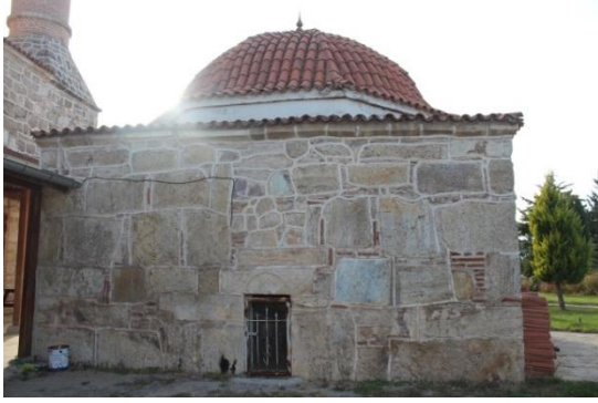
Foto.44: Dedeköy Cami Türbesi, Doğu Cephe
