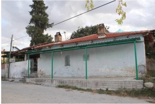
Foto. 174: Karaca Ahmed Sultan Türbesi, Genel Görünüm
