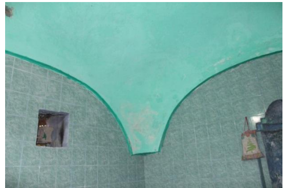
Foto. 181: Karaca Ahmed Sultan Türbesi, Kubbe Geçişleri
