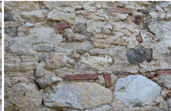
Foto. 148: Aşağı Cami Türbe, Doğu Cephe Duvarından Detay
