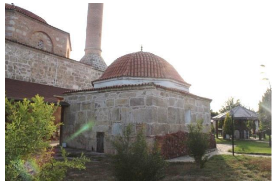
Foto. 41: Dedeky Cami Trbesi Kuzeydoėu Cephesi
