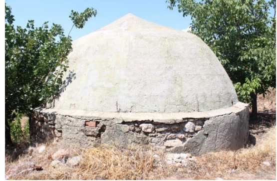
Foto. 229: Sadık Dede Türbesi, Arka Cephesi
