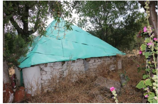
Foto.256: Aşağı Tekke Dede Türbesi, Güney Cephesi
