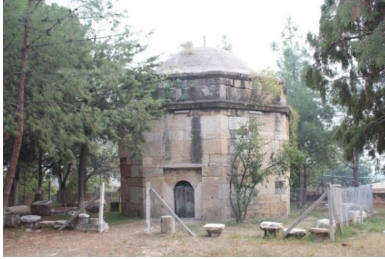
Foto. 82: Büyük Tekke (Emir Sultan) Türbesi, Genel Görünüm
