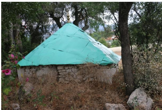
Foto.257: Aşağı Tekke Dede Türbesi, Doğu Cephesi
