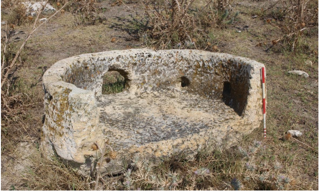
Figür 48. Su Dağıtım Terminaline ait Castellum Divisorium.
