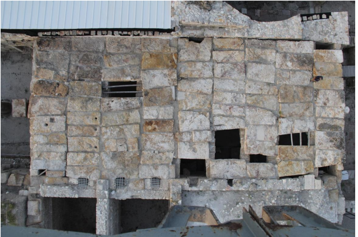
Figür 59. Doğu-batı doğrultulu Kemerli Yapı'nın ve çatı bloklarının genel görünümü.
