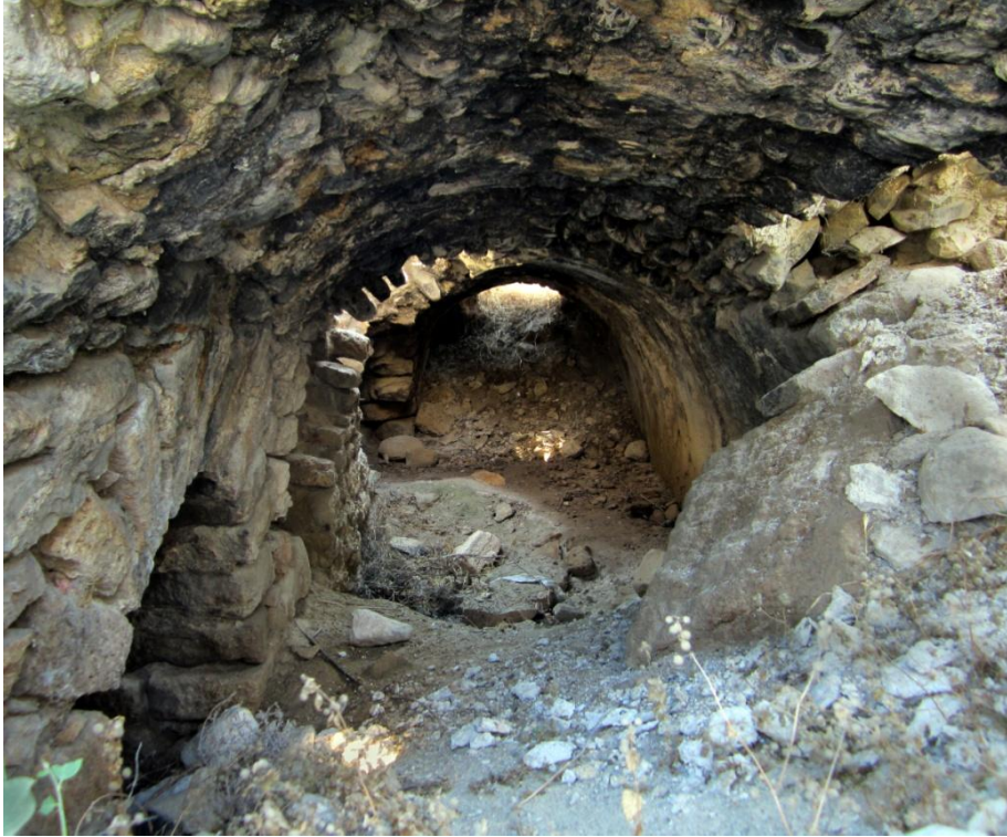
Figür 45. Tiyatro Hamamı Sarnıcı'nın doğu-batı girişli koridoru.
