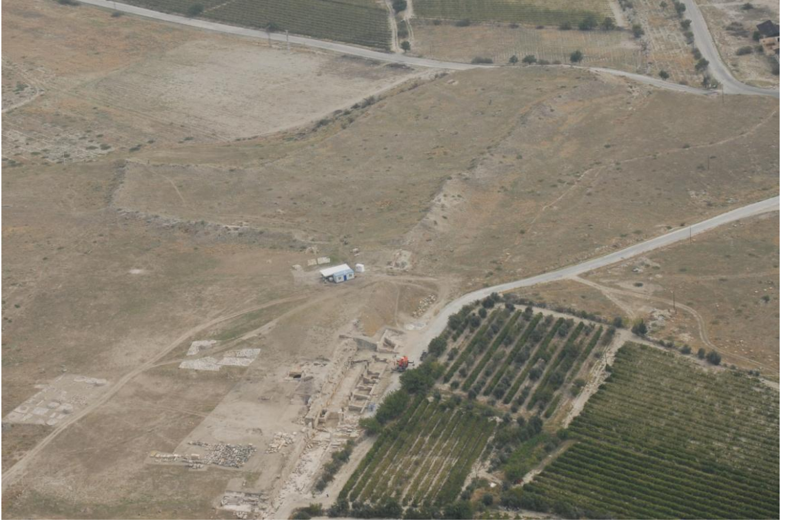
Figür 6. Güney surları genel görünüm.
