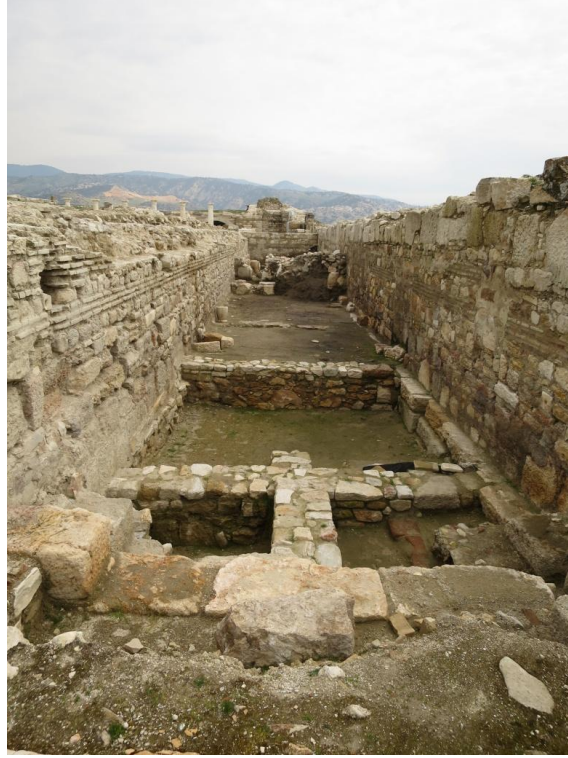
Figür 34. Güney oturma basamaklarının güney duvarı arkasında yer alan dükkânlar.
