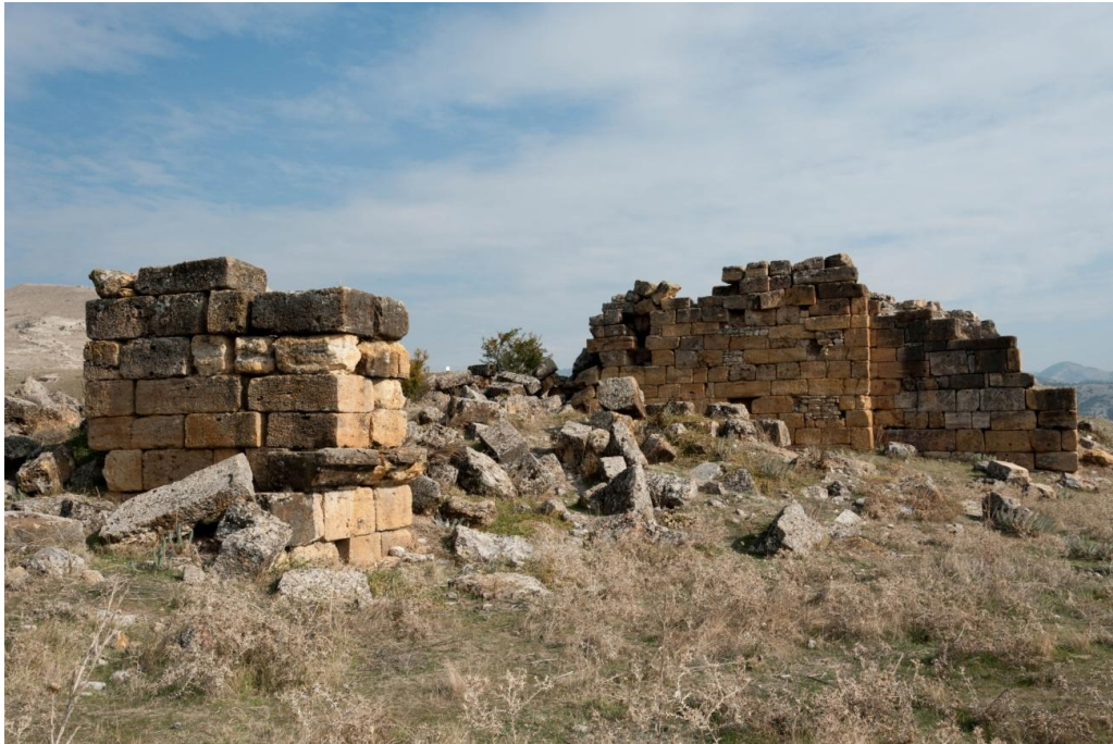
Figür 21. Büyük Hamam Yapısı güneybatıdan görünüm.
