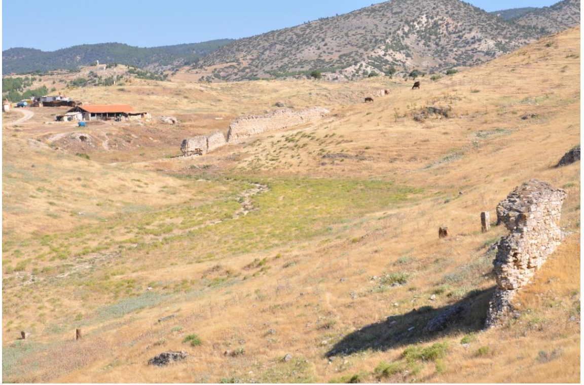
Figür 8. Batı surları genel görünüm.
