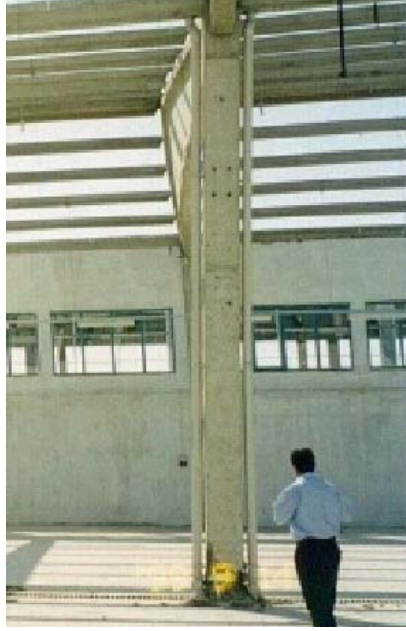
Şekil 3.4: Trapez kirişlerde yanal ötelenme ve kolon alt ucunda mafsallaşma
