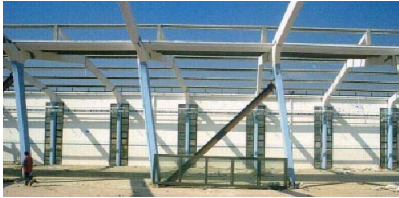
Şekil 3.3: Kolonlarda büyük yatay ötelenme hasarı.
