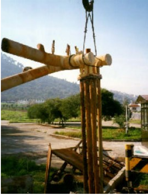
Şekil 5.12 Balçova' da kurulan bir kuyu içi ısı eşanjörünün resmi (Lund 1999)
