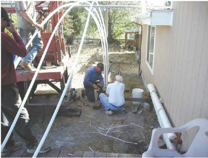
Şekil 5.6 Ucuna eski ısı eşanjörünün siyah çelik borusu bağlanmış 2 polietilen U tüpünün kurulmadan önceki durumu (Chiason vd 2005)
