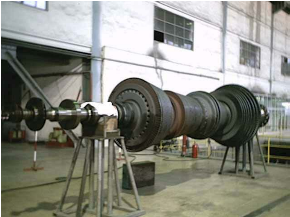
Şekil 4.3 Türbin iç görünüşü (Anonim 2006)
