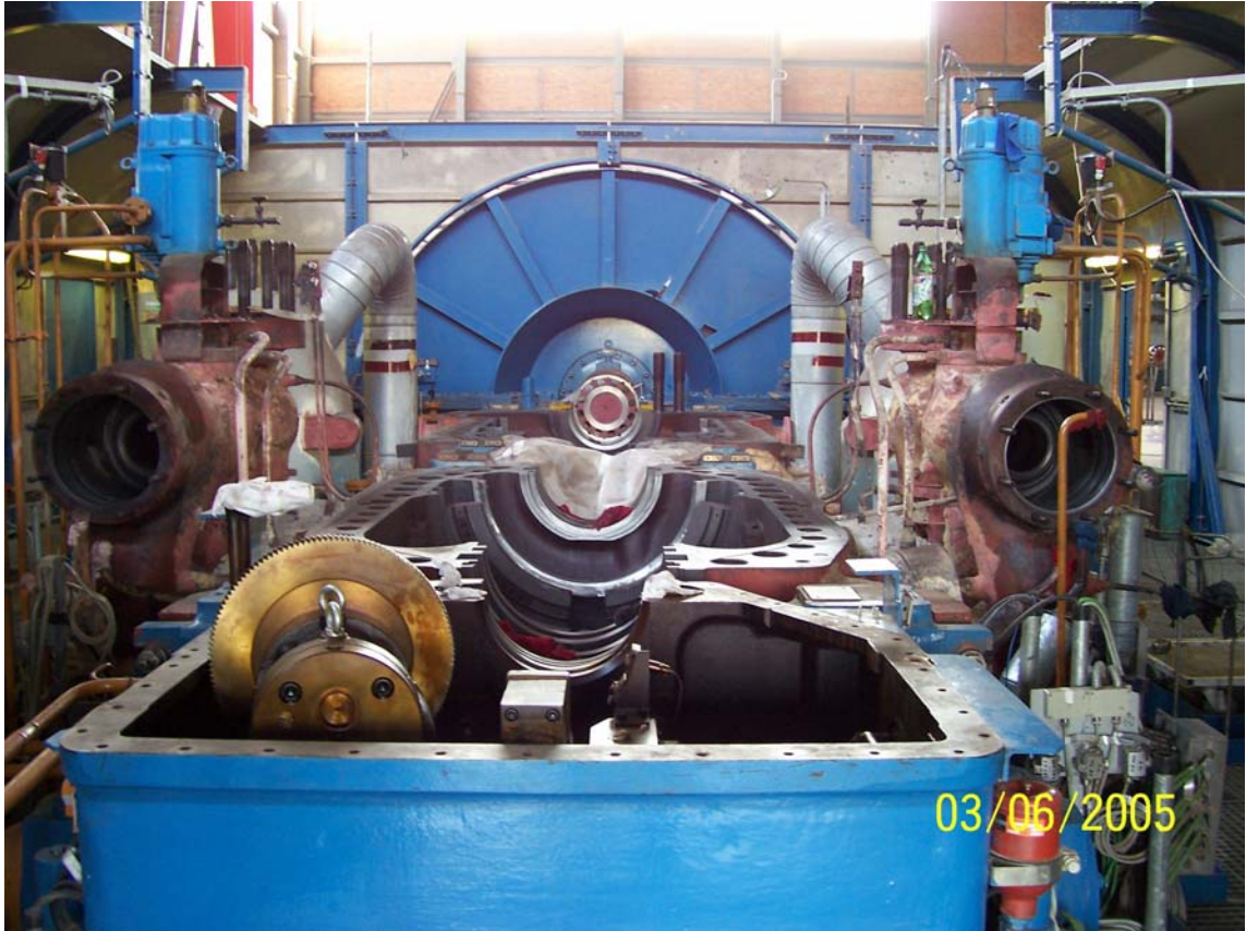
Şekil 4.4 Türbin yatağı ve alternatör mili (Anonim 2006)
