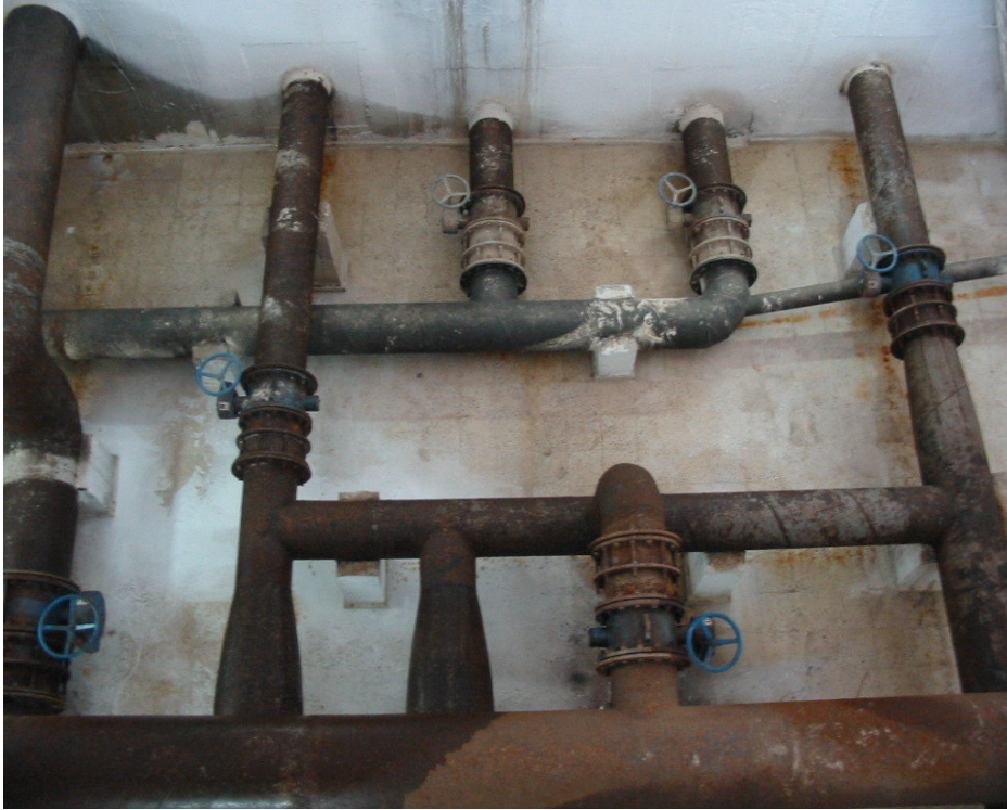
Şekil 3.17 Yeni Kuruçay su deposu içi
