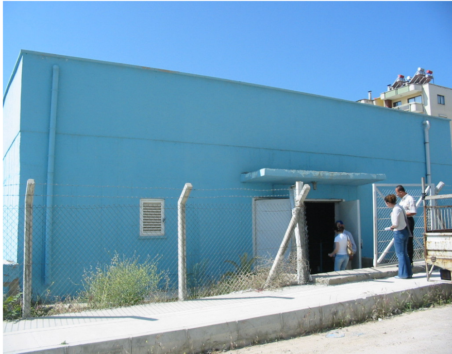
Şekil 3.16 Yeni Kuruçay su deposu
