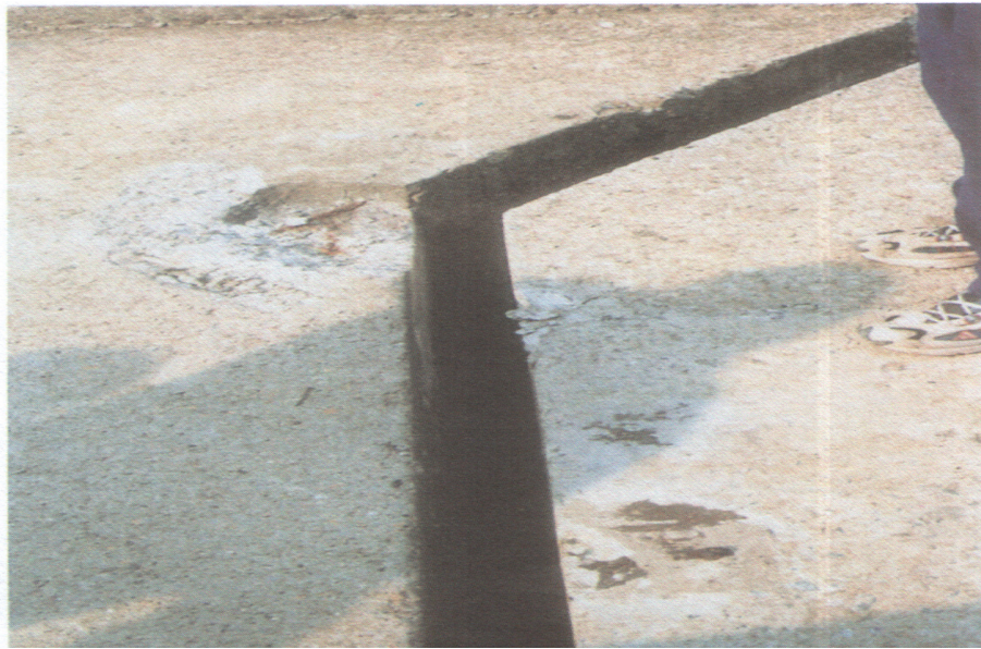
Şekil 5.7 Petkim rafinerisi iskelesi üzerinde yatay deplasman sonucu meydana gelen yanıl hareket (yaklaşık 15cm) (Sucuoğlu vd 2000)
