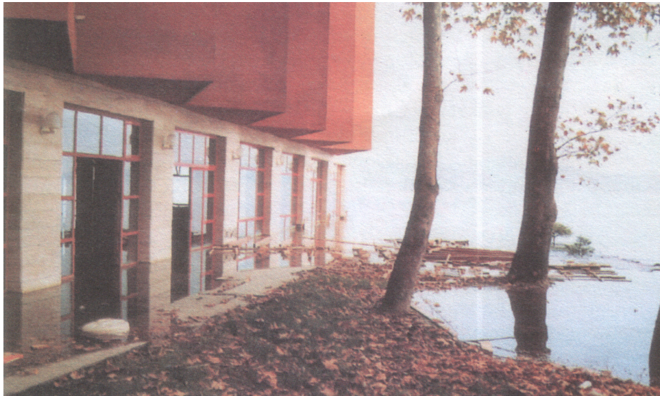
Şekil 5.4 1999 Kocaeli depreminde Sapanca Gölünün Adapazarı'na yaklaşık 5km mesafede yer alan doğu kıyısında sivilaşmaya bağlı olduğu düşünülen oturmalar ve denize doğru yanal yayılımlar sonucunda sahil şeridi kısmen gölün suları altında kalmıştır (Sucuoğlu vd 2000)
