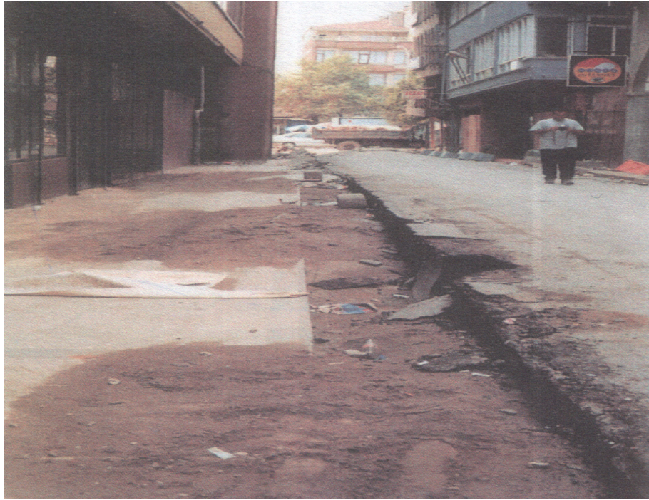
Şekil 5.12 Adapazarı'nda Çark Caddesi civarında bir sokak boyunca zemin yüzeyine fişkırılmış silt ve ince kum öbekleri (Sucuoğlu vd 2000)
