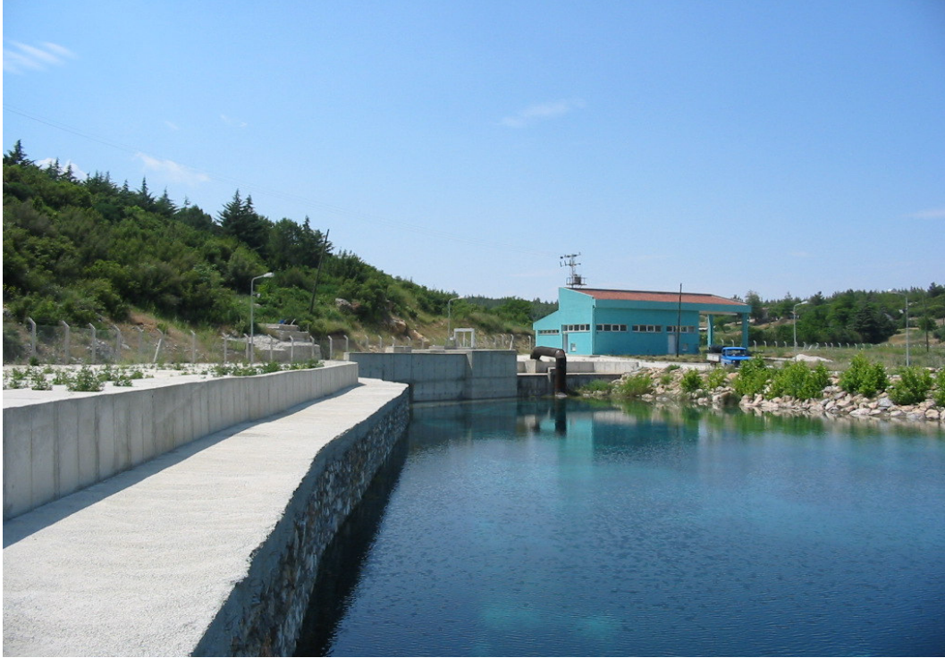
Şekil 3.8 Gökpınar göleti ve klorlama ünitesi binası
