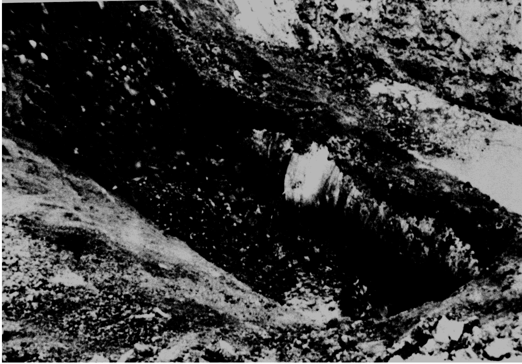
Şekil 4.4 1985 Michoacan Meksika depreminde asbest boruda meydana gelen sızıntı (Ayala ve O'Rourke 1989)
