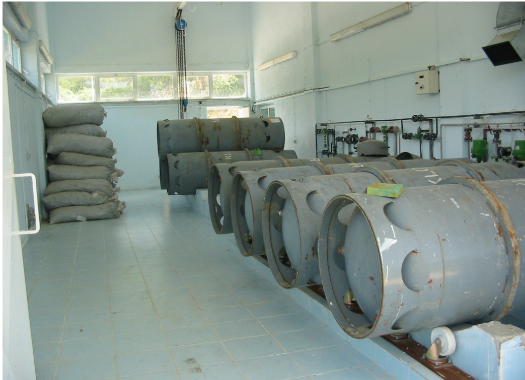
Şekil 3.9 Klorlama ünitesi binası
