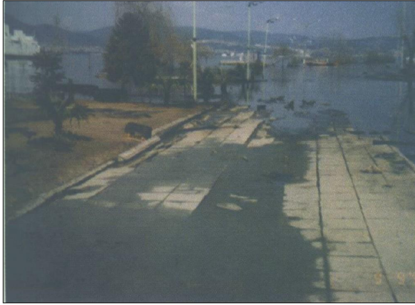
Şekil 4.6: 1999 Kocaeli depreminde, Gölcük-Kavaklı'da yan al yayılma ile denize sürüklenen sahil yolu (Ulusay, 2000).
