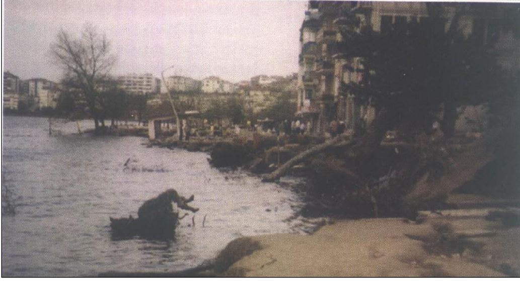
Şekil 4.11: 1999 Kocaeli depreminde, Değirmendere’de denize doğru gelişen akma sızılaşması (Ulusay, 2000).
