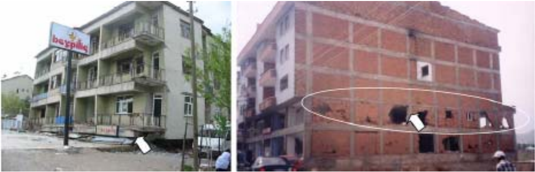
Şekil 2.5 : Deprem enerjisinin tek bir katta yoğunlaşması
