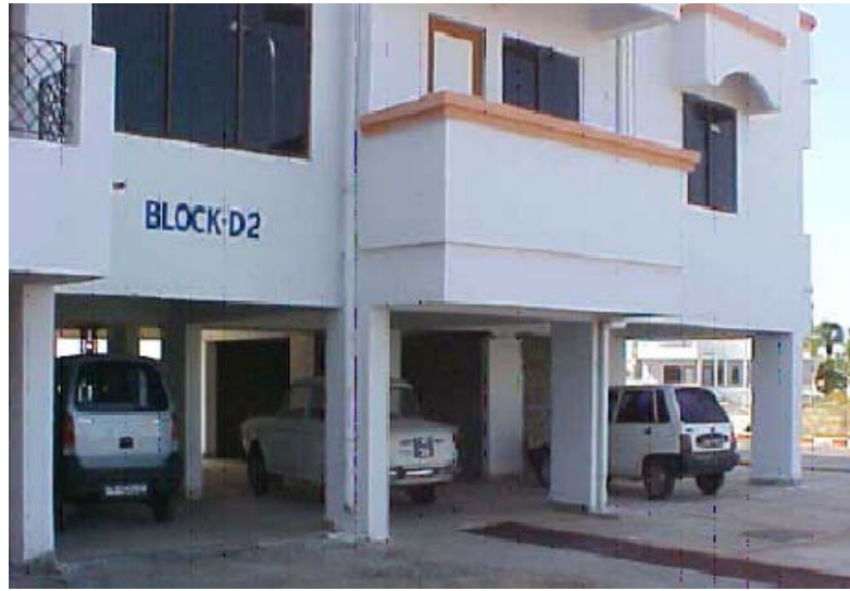
Şekil 2.1 : Zemin katta duvarların bulunmaması nedeniyle yumuşak kat oluşumu
