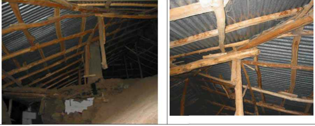
Şekil 3.9: Su izolasyonu için yapılan çatı
