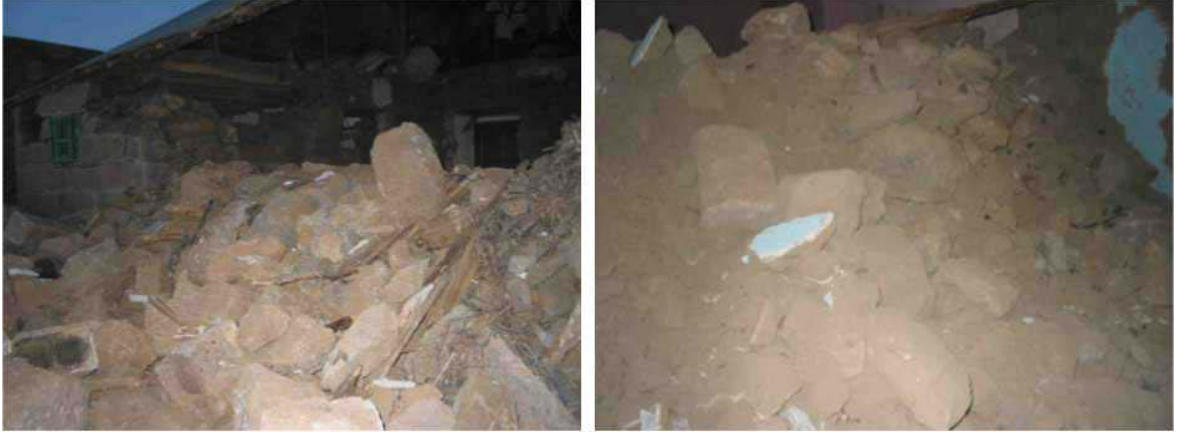
Şekil 3.12: Taş ve toprak yığına haline gelen duvarlar
