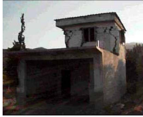
Şekil 3.40: Alt katı betonarme üst katı yığma olan bir bağ evinde üst kattaki hasar
