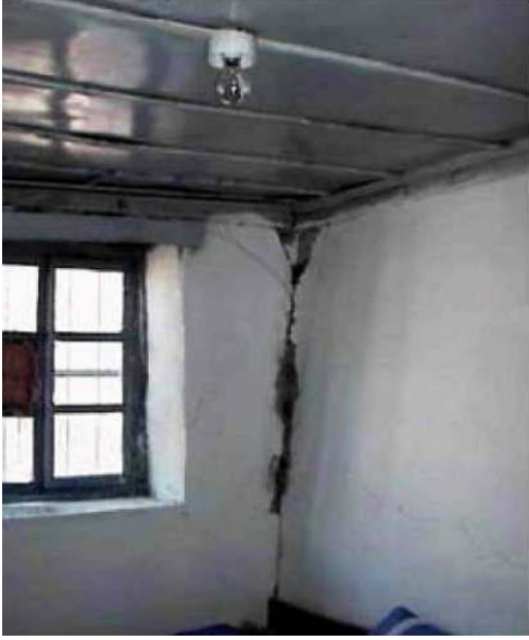
Şekil 3.30: Hasar gören yapıda köşe noktalarının görünüşü
