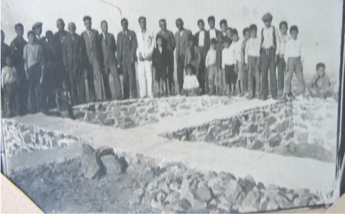
Şekil 4.8: Yapıda uygulanan duvar altı doğal taş temel (Hastane arşivinden alınmıştır)
