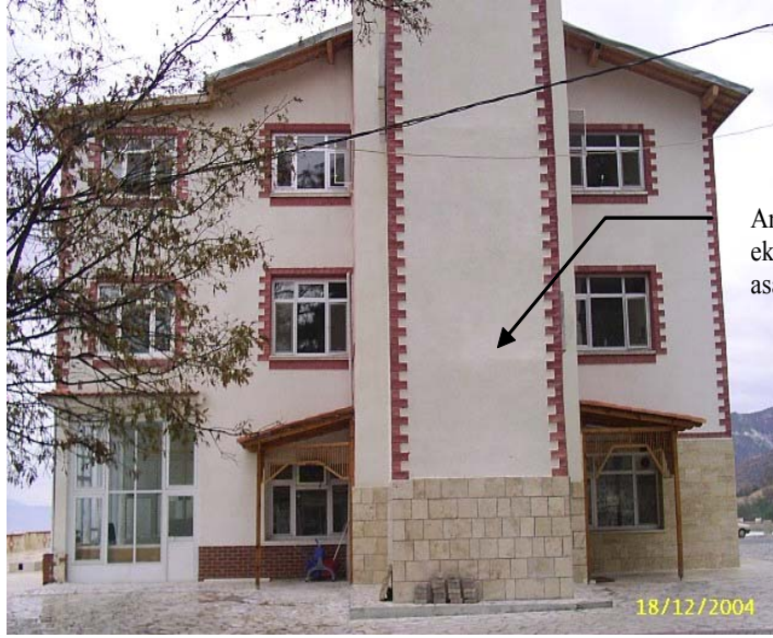
Şekil 4.7: Ana binaya sonradan eklenen asansör kovası
