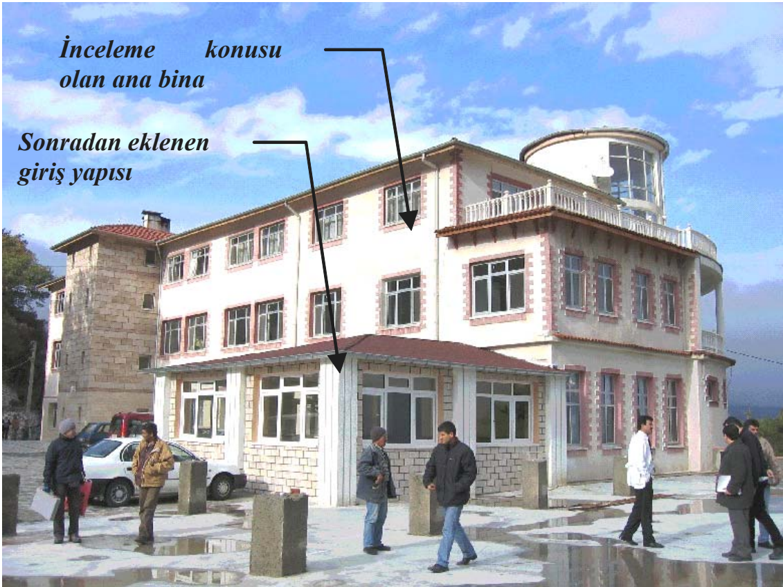
Şekil 4.4:Göğüs hastalıkları hastanesi ana binası ve eklenen giriş holü
