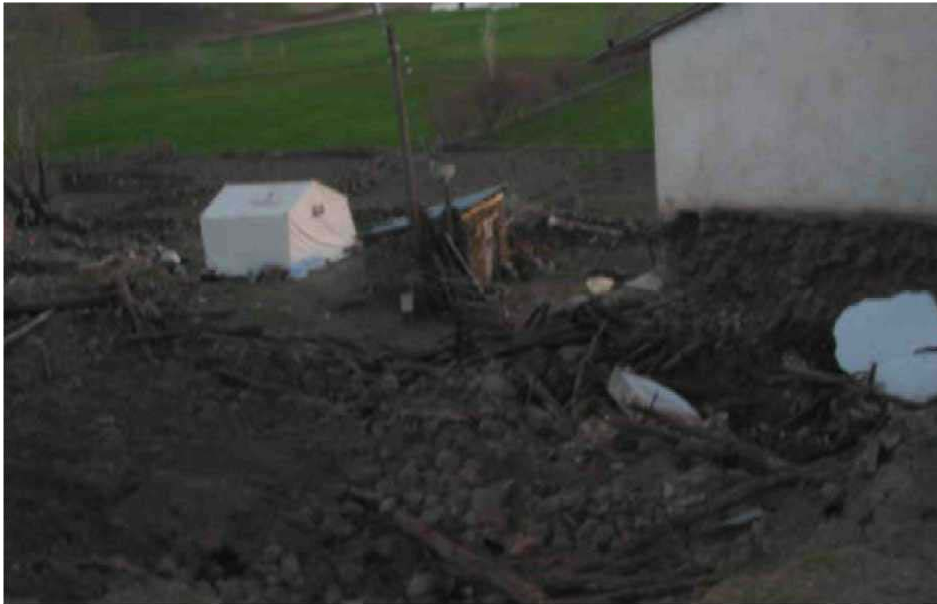
Şekil 3.11: Yıkılan bir hayvan barınağı
