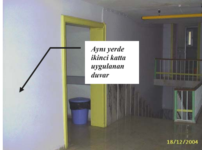
Şekil 4.22: Aynı yerde, ikinci katta uygulanan duvar
