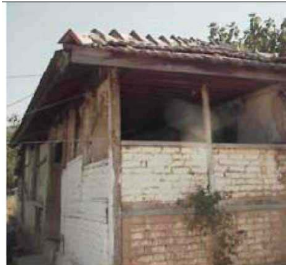
Şekil 3.28: Yığma yapı yapım hataları ve oluşan hasarlar.
