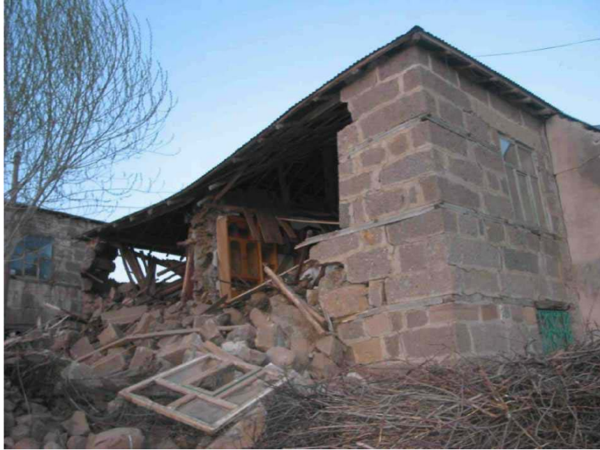
Şekil 3.2: Sadece görünüş esas alınarak yapılan duvar
