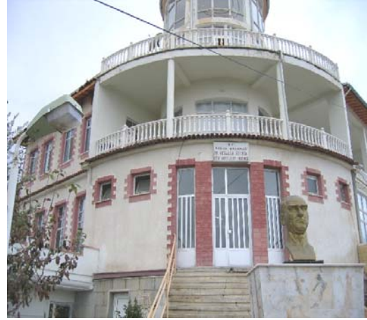
Şekil 4.26: Mevcut durum (Seyirlik teraslar oda haline getirilmiş)
