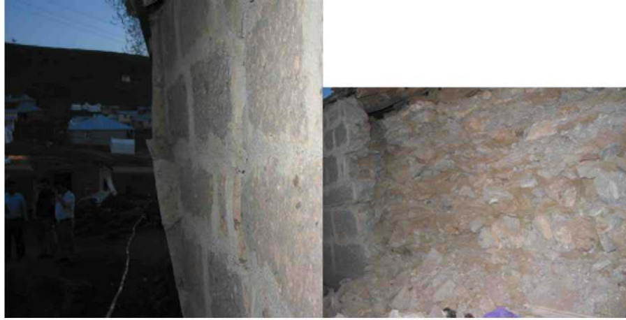
Şekil 3.3: Yatay ötelenme ile Dış duvarda ayrılan taş kaplama ve duvarın diğer kısmı
