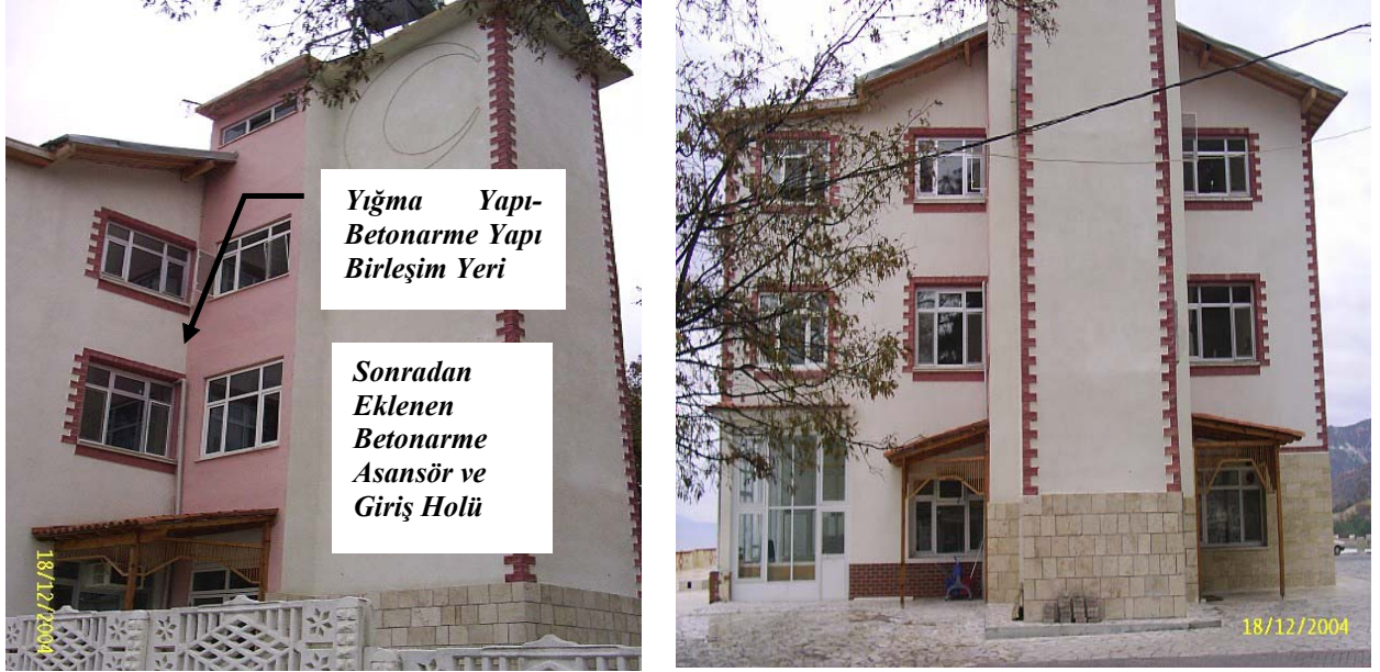
Şekil 4.12: Sonradan eklenen asansör ve giriş holünün yığma yapıya birleşimi
