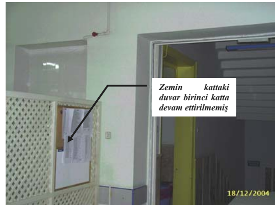
Şekil 4.21: Zemin katta var olan duvar birinci katta kaldırılmış
