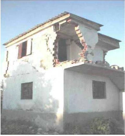
Şekil 3.40: Alt katı betonarme üst katı yığma olan bir bağ evinde üst kattaki hasar
