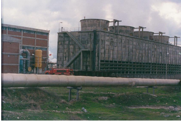
Şekil 3.7: Tek buharlaştırmalı bir santral örneği: Kızıldere sahası
