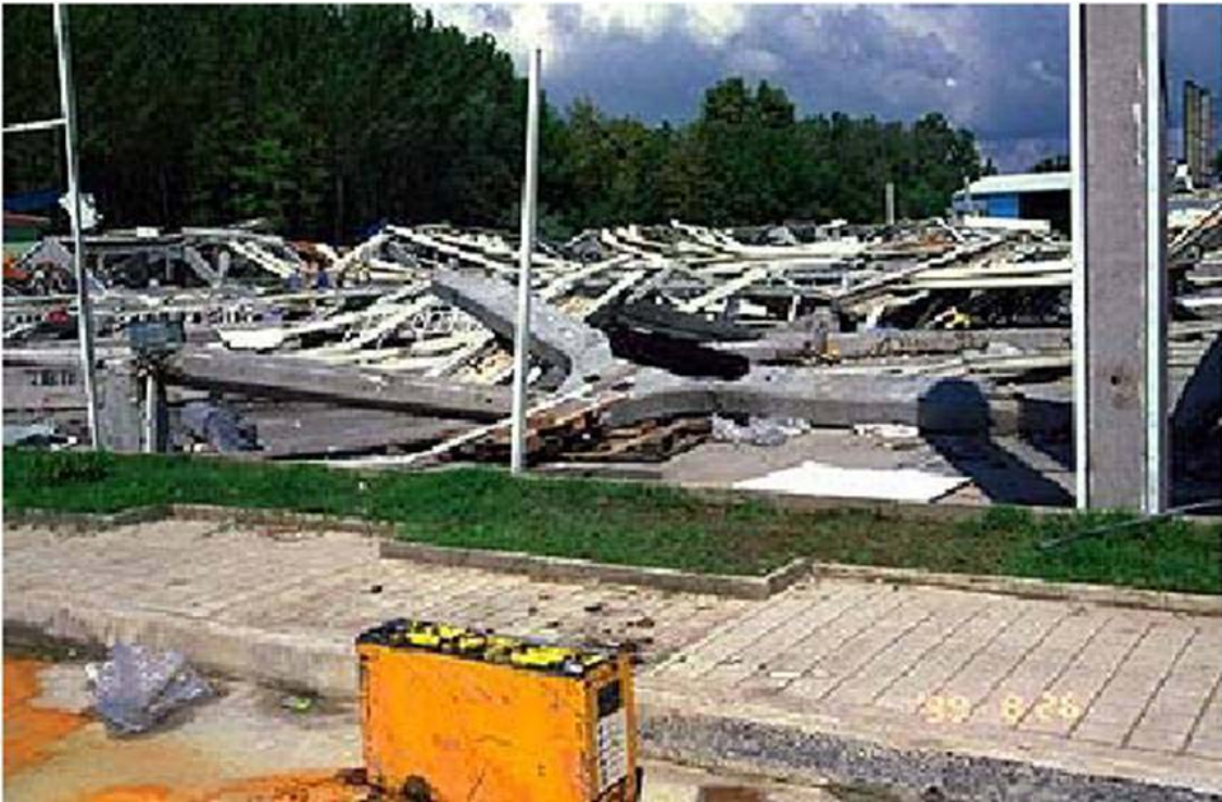
Şekil 2.7: 1999 Marmara Depreminde Göçmüş Yapı
