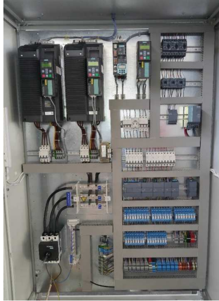
Şekil 3.6: PLC kontrollü örnek bir endüstriyel otomasyon panosu (Foto: M. Y. Toylan)
