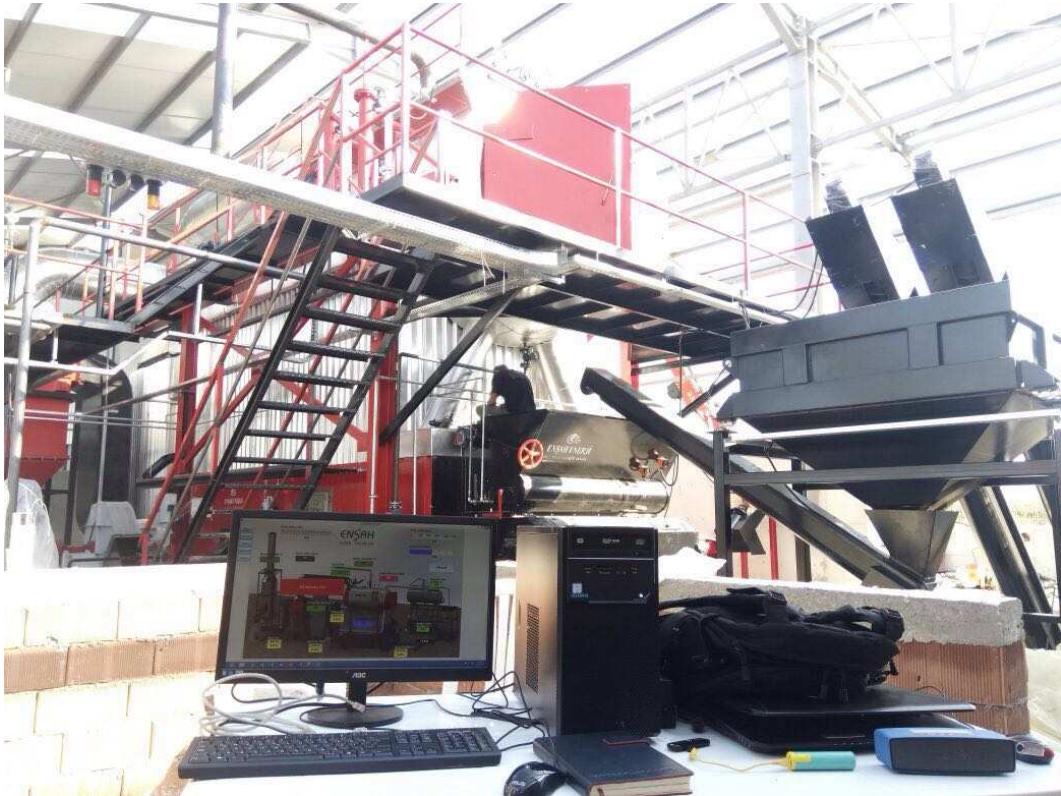
Şekil 3.5: Scada sistemli bir kazan otomasyonu (Foto: M. Y. Toyplan)
