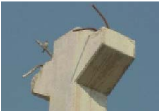
Şekil 3.13 Pimli bağlantı ve bağlantı noktasından kopan makas (Ersoy vd 2000)
