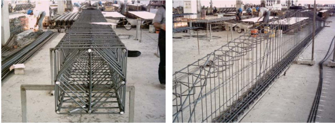
Şekil 3.9 Kolonların ve çatı makaslarının donatı düzenleri örneği
