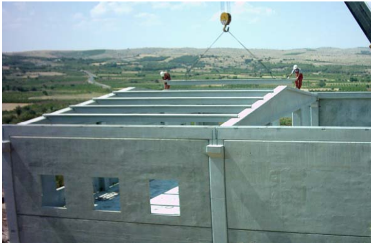
Şekil 3.6 Çatı makası, oluk ve aşık montaj görüntüsü
