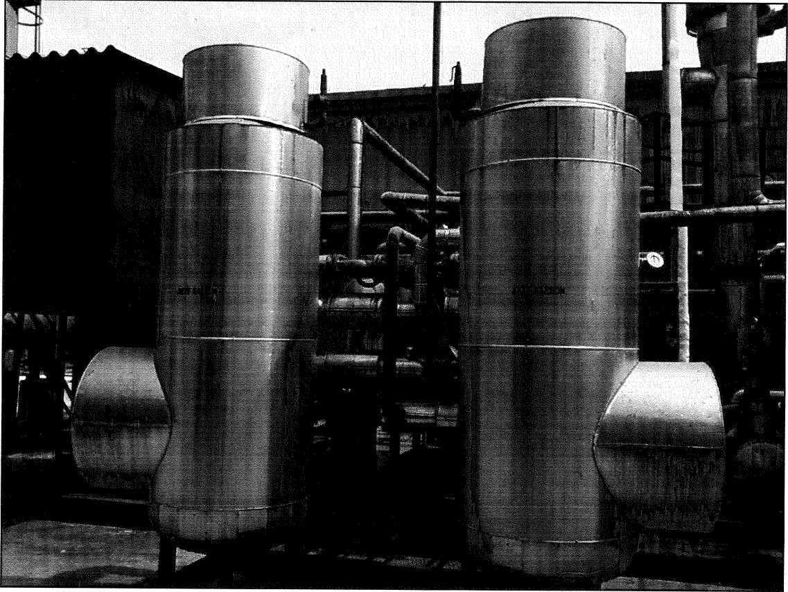
Şekil 6.6. D-04A ve D-04B aktif karbon kuleleri
