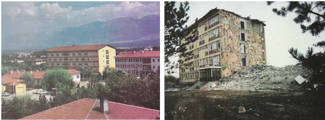
Şekil 2.7 Sağlık Meslek Lisesi binasının depremden önce ve sonra görünümü
