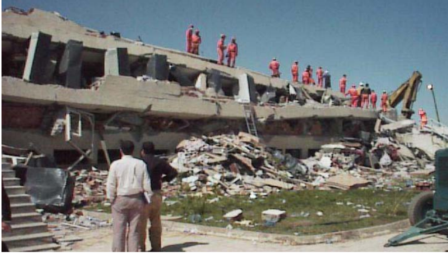
Şekil 2.4 Pansiyon binasının katlarının bir biri üstüne çökmesi
