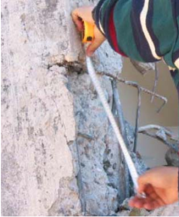
Şekil 2.2 Yetersiz sargı donatısı
