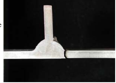
c. Köşe dikişi, Kırılma ısı tesiri altındaki bölgede ve dikiş geçiş bölgesinde
