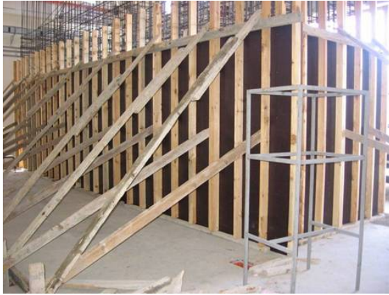
Reaksiyon duvarı kalıbı
