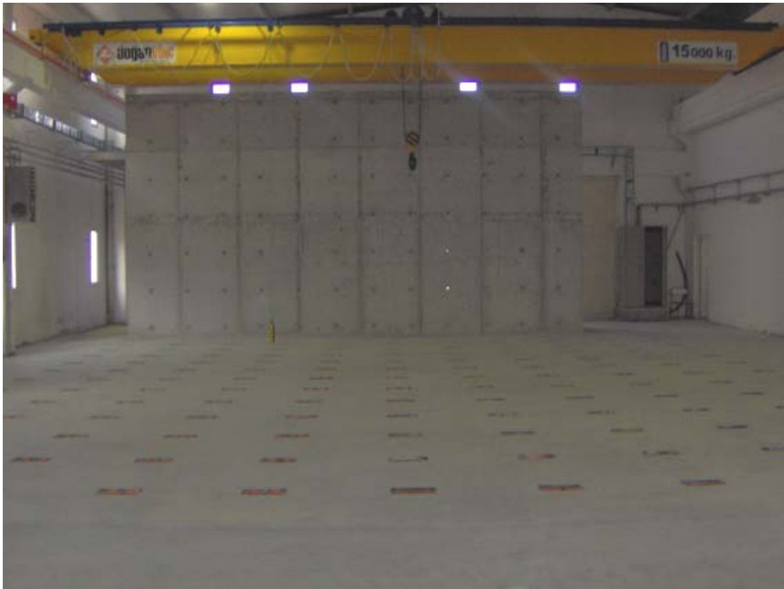
Şekil 3.34 Laboratuvarın içine yapılan galerisiz kuvvetli döşeme ve reaksiyon duvarı
