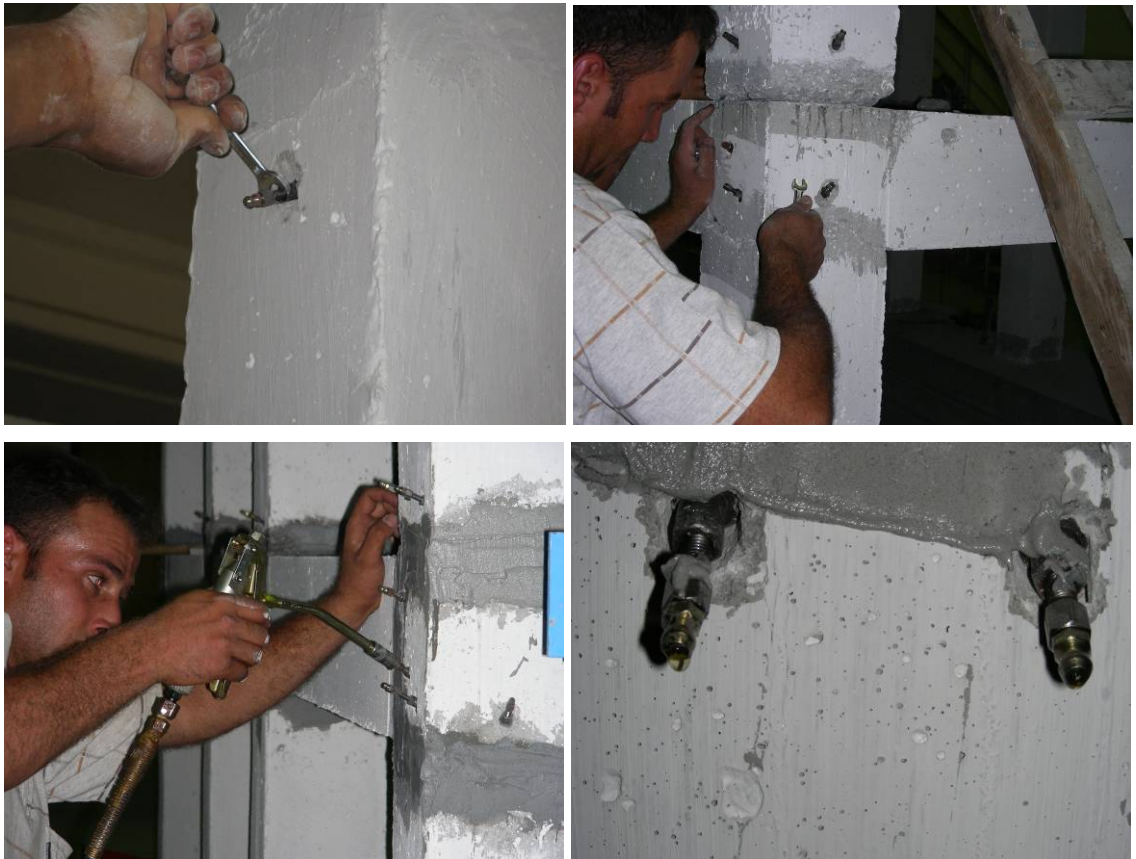
Şekil 3.24 Çatlak bölgelerde epoksi enjeksiyonu uygulaması
