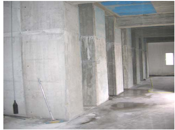
Reaksiyon duvarı arka görünüş
