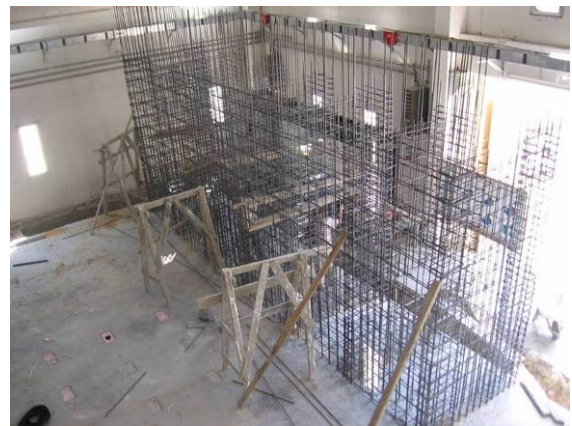
Reaksiyon duvarı donatılarının bağlanması
