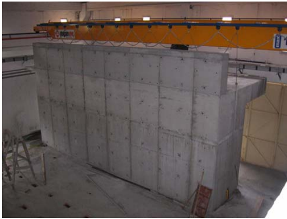
Reaksiyon duvarı ön görünüş
