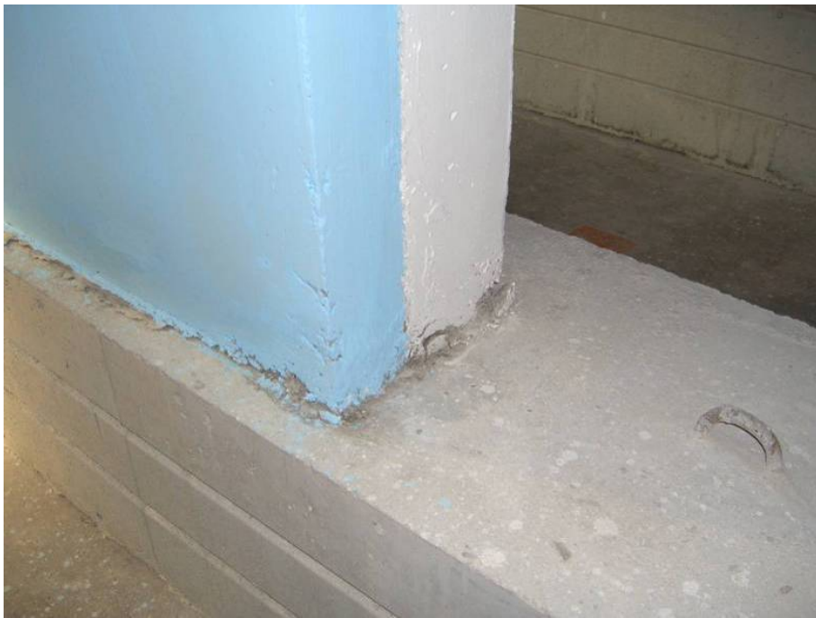
Şekil 4.48 Perde tabanında kayma hasarı başlangıcı (sol aks)
