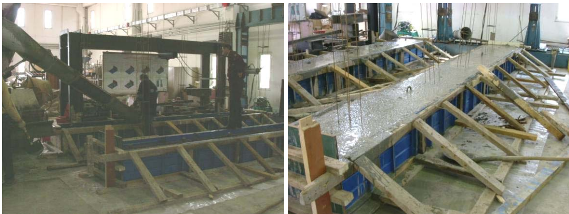
Şekil 3.17 Temel betonunun dökülmesi
