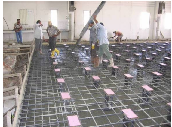
Beton dökülmesi
