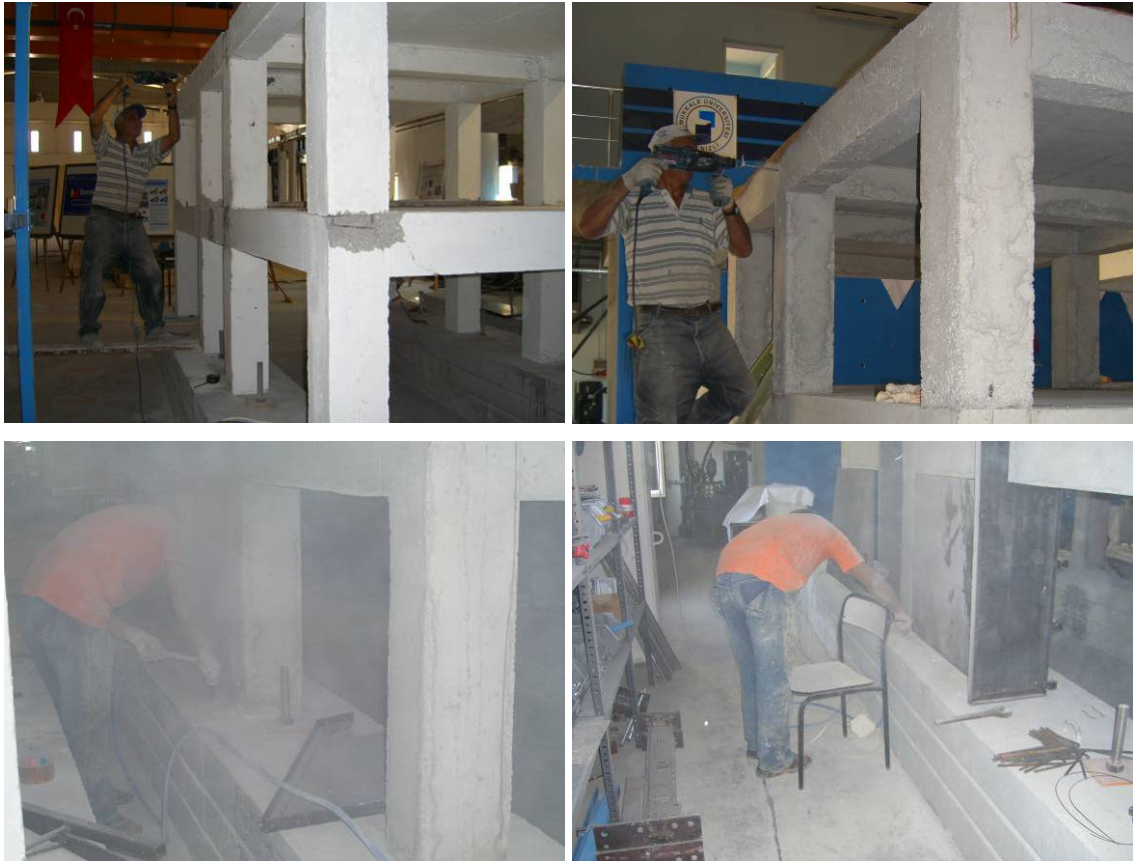
Şekil 3.25 Ankraj deliklerinin açılması ve temizlenmesi
