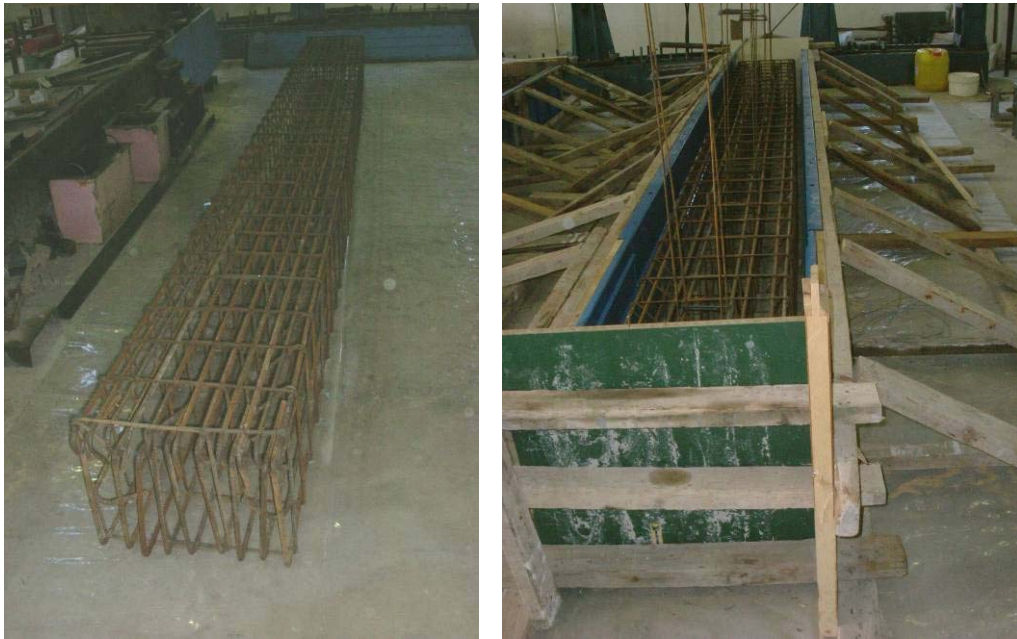
Şekil 3.16 Temel donatıları ve kalıbı
