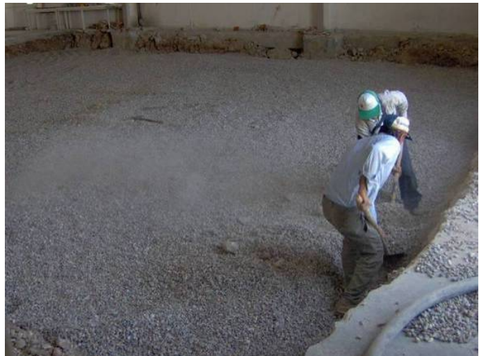
Şekil 3.38 Kuvvetli döşeme ve reaksiyon duvarı imalat aşamaları - 1
