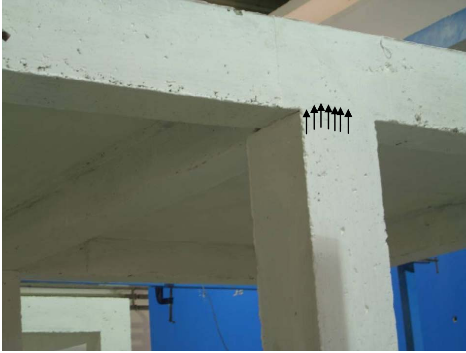
Şekil 4.8 Numunede ilk çatlak oluşumu
