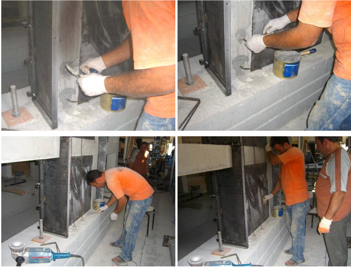
Şekil 3.26 Dış-perde ankrajlarının yapılması
