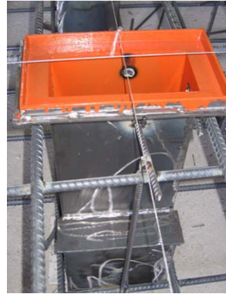
Ankraj kutularının mevcut demirlere ve tesviye betonuna tutturulması
