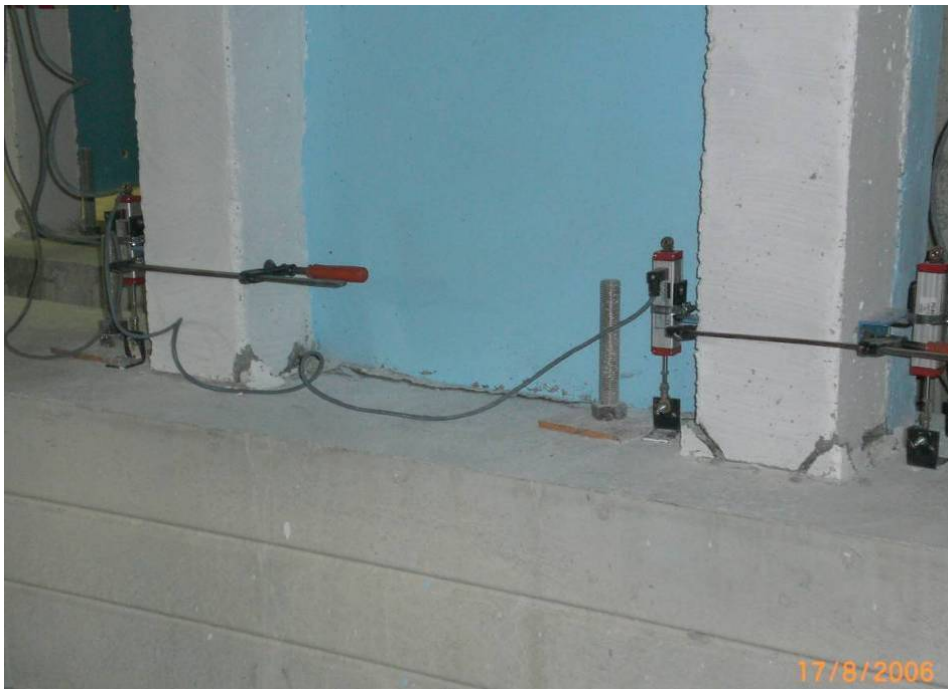
Şekil 4.46 Perdeye bağlı kolonda ezilme ve kabuk dökülmesi
