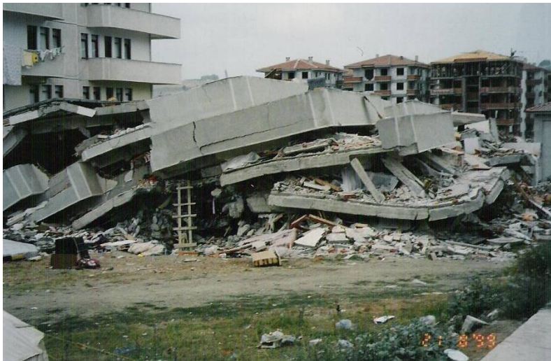
Şekil 3.9 Kuvvetli kiriş-zayıf kolon oluşumu (Kaplan 1999)
