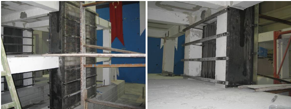
Şekil 3.27 Dış perde kalıplarının kapatılması
