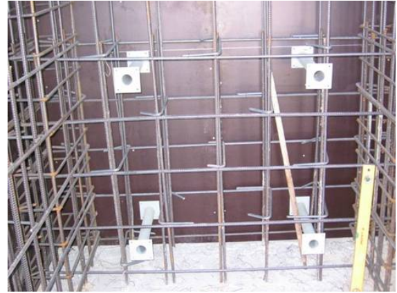
Reaksiyon duvarı ankraj kılıflarının yerleştirilmesi
