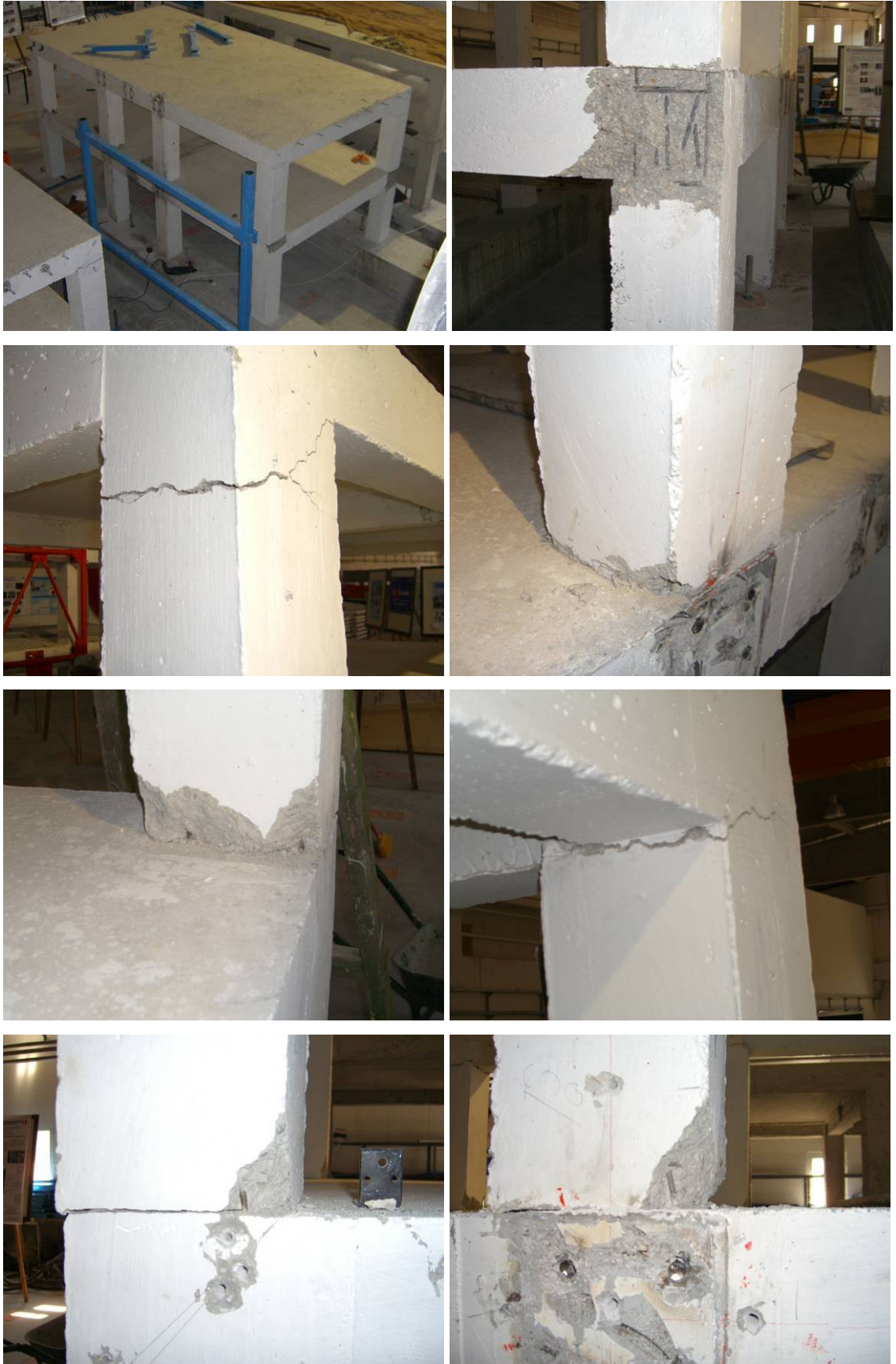
Şekil 3.21 Hasarlı numunenin genel görünüşü ve hasarlar
