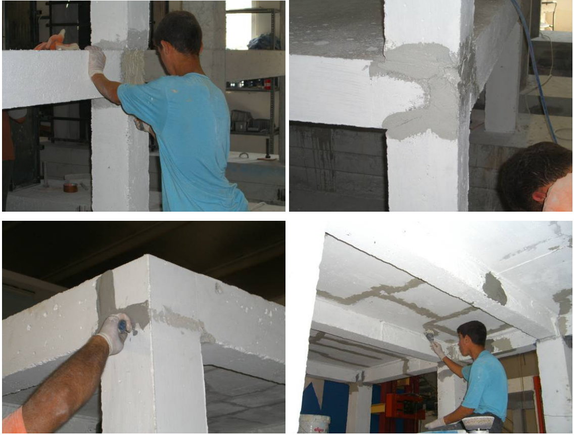
Şekil 3.23 Çatlakların ve kabuk dökülmelerinin tamir harcı ile onarımı
