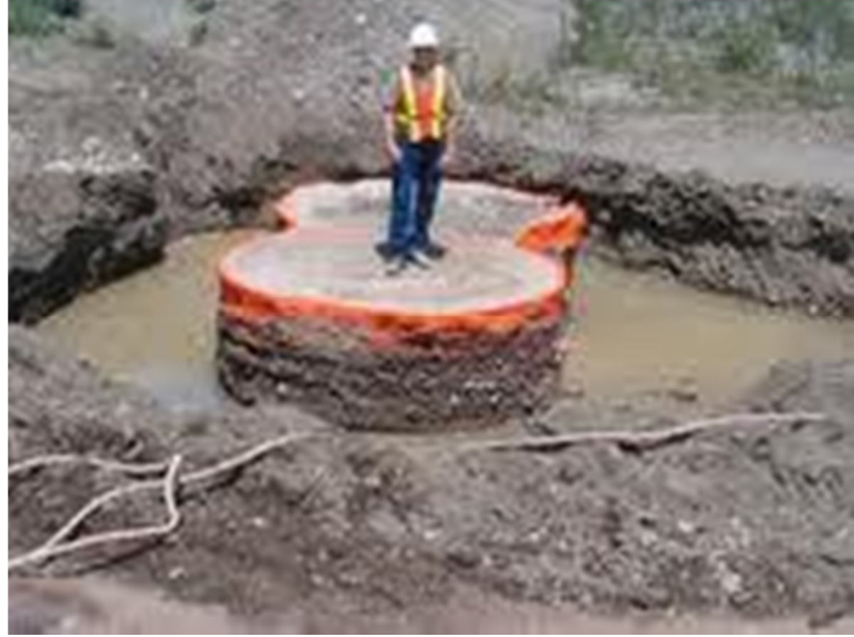
Şekil 10 : Jet 2 Yöntemi Kullanılarak Oluşturulmuş Kolon [Y2]
