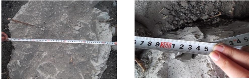
Şekil 17 : Kazıkların Çap Kontrolü [Y2]
