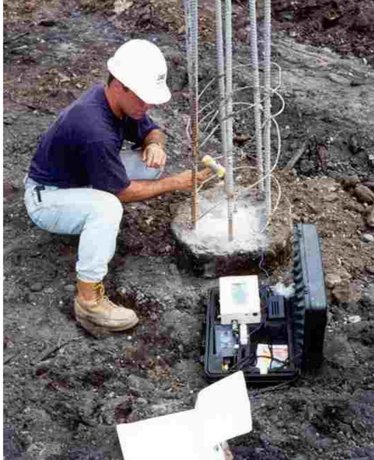
Şekil 37 : Integrity test uygulaması [Y3]
