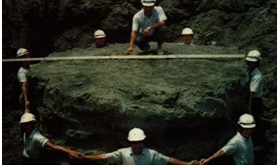
Şekil 12 : Jet 3 Yöntemi Kullanılarak Oluşturulmuş Kolon [Y2]
