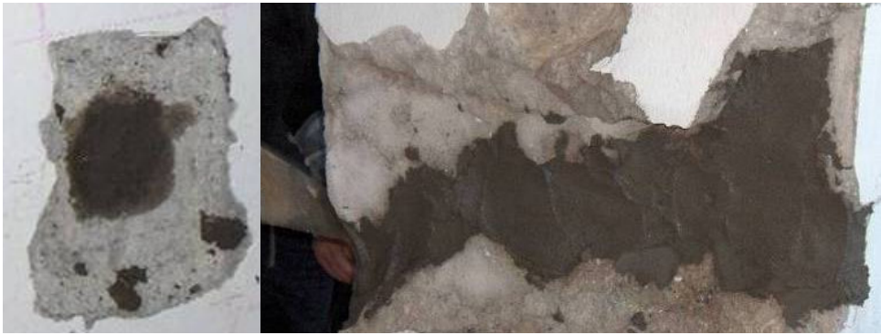
Şekil 4.13 Açılan noktaların özel tamir harcı ile kapatılması
