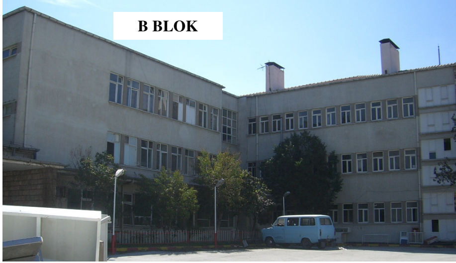
Şekil 4.2 İncelenen yapıların görünüşü (Kaplan vd 2006).
