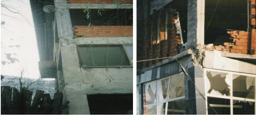
Şekil 3.5 Birleşim bölgelerinde hasar oluşumu (Kaplan 2004).
