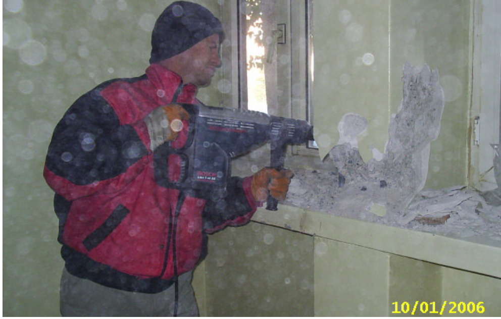
Şekil 4.6 Kolonlarda pas payının kaldırılması.
