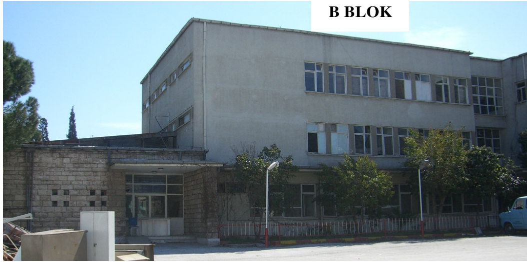
Şekil 4.3 İncelenen yapıların görünüşü (Kaplan vd 2006).
