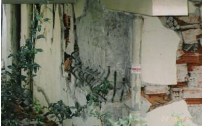
Şekil 3.7 İyi sargılanmamış elemanda donatı burkulması ve göbek betonunun dağılması (Kaplan 2004).
