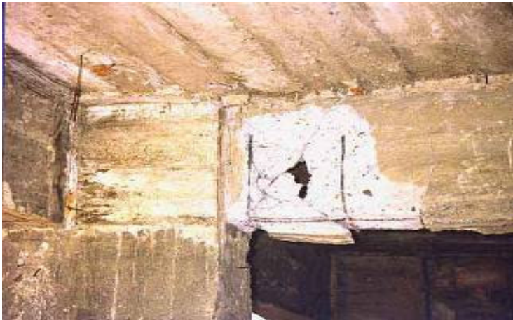
Şekil 3.6 Yetersiz sargılanan kirişte kesme hasarı (Kaplan 2004).
