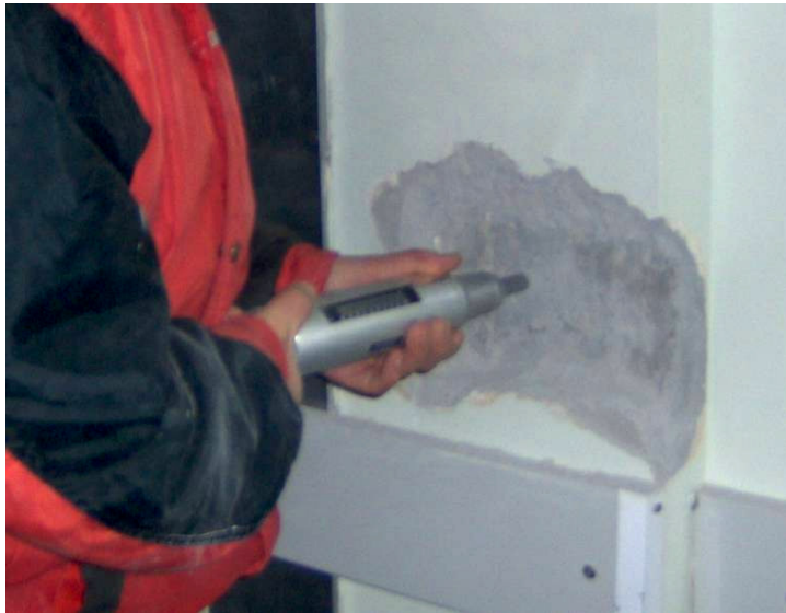
Şekil 4.11 Beton tabancası deneyi yapılışı
