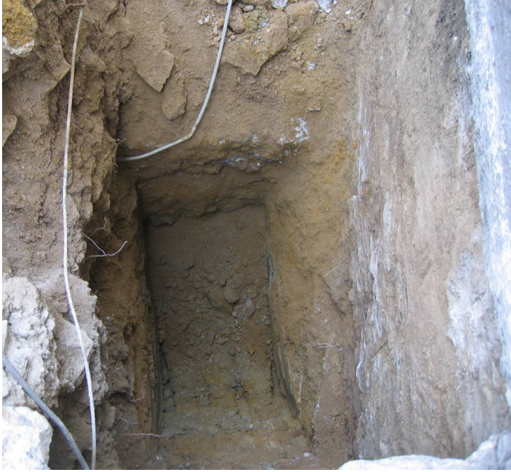
Şekil 4.4 İncelenen yapıda zemin ve temel durumu için açılan gözlem çukuru (Kaplan vd 2006).
