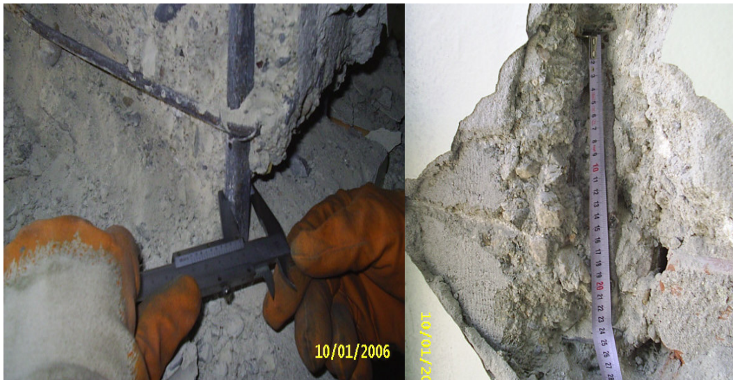
Şekil 4.7 Donatı çapının ve konumunun ölçülmesi
