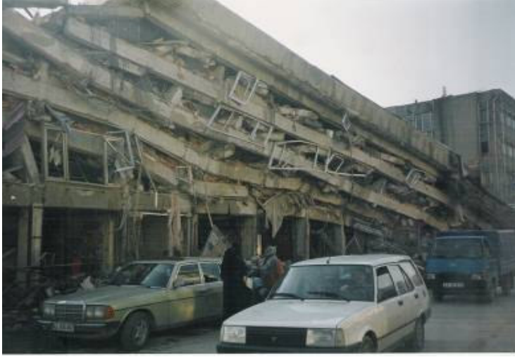
Şekil 3.3 Kuvvetli kiriş-Zayıf kolon hasarı (Kaplan 2004).
