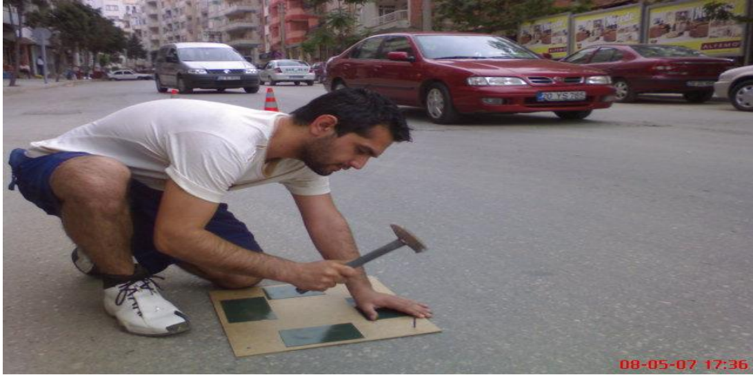
Şekil 4.5 : Cihazın asfalta monte edilmesi
