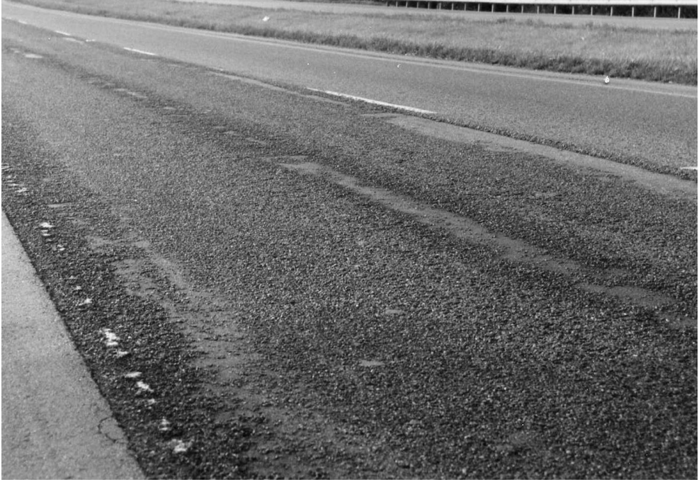
Şekil 2.3 : Esnek kaplama tabakasında oluřan soyulma / sökölme (Asphalt İnstitute)
