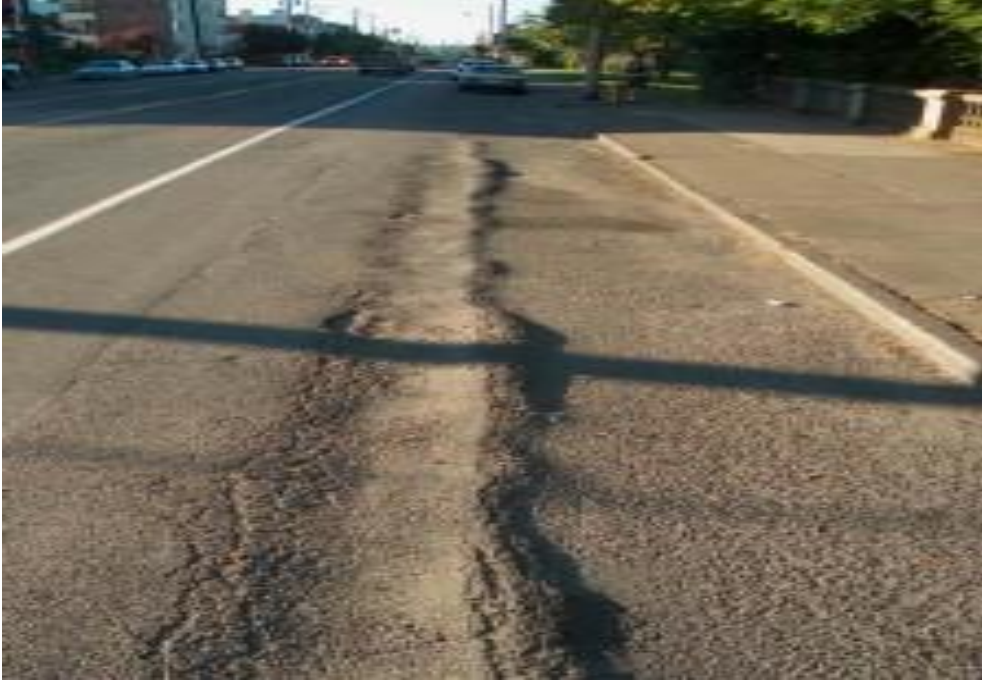
Şekil 2.4 : Esnek kaplama tabakasında oluşan yüksek şiddette tekerlek izi (Pavement Maintenance And Rehabilitation 2011)
