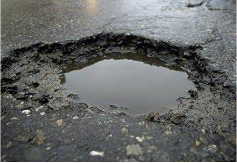
Şekil 2.2 : Esnek kaplama tabakasında oluşan çukurlaşma ( SABLE Asphalt )
