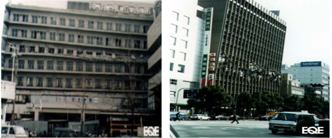
Şekil 2.4 1995 Kobe depreminde üst katlarda yumuşak kat mekanizması
