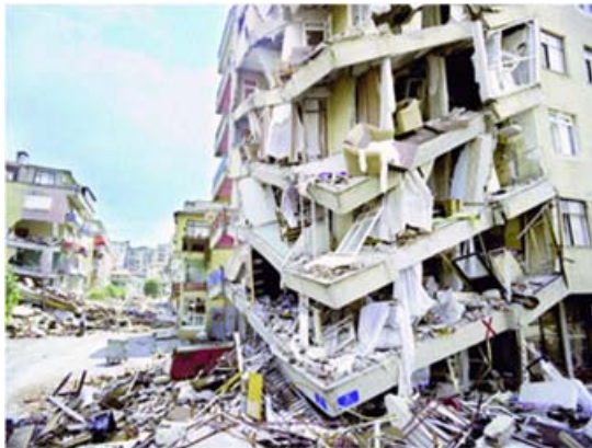
Şekil 2.7 1999 Marmara depreminde çıkma hasarı
