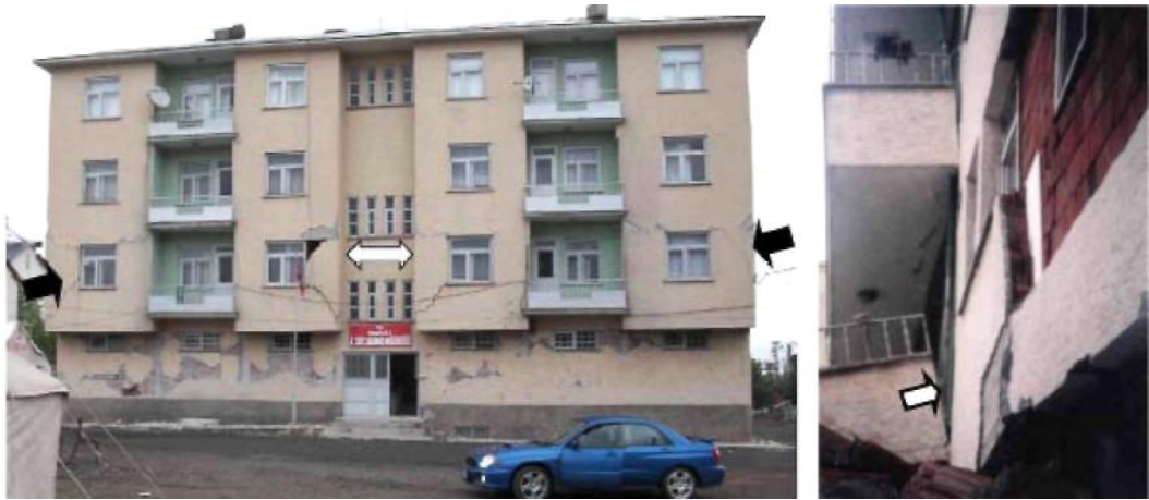
Şekil 2.8 2003 Bingöl depreminde hasar görmüş ağır çıkmalara sahip bir yapı
