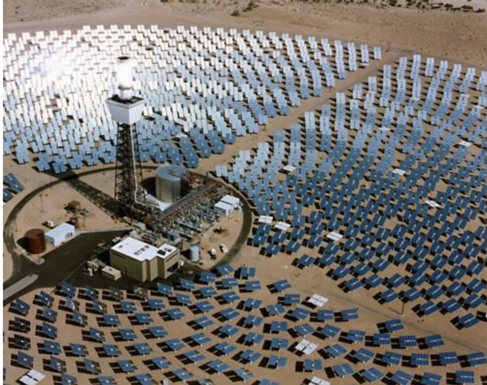
Şekil 3.11. Güç kulesi (Kıncay, 2008)
