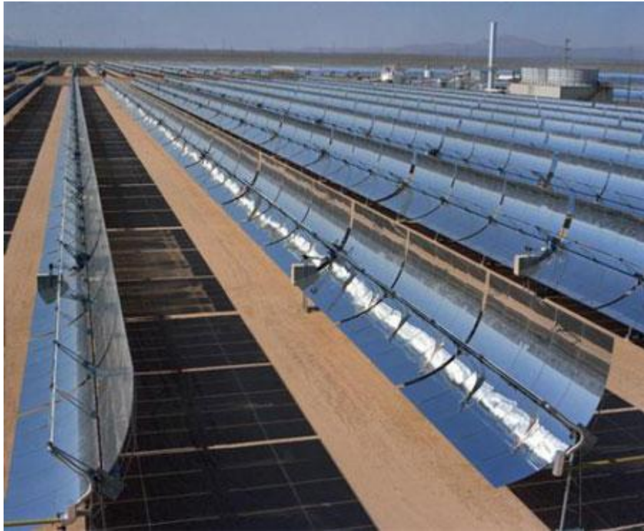
Şekil 4.2. Parabolik güneş santrallerinde yoğunlaştırıcıların dizilişi (Kearney, 2007)
