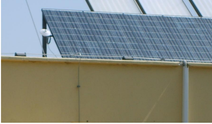
Şekil 5.11 Sabit Güneş Pili Panellerine Monte Edilen Pyranometre
