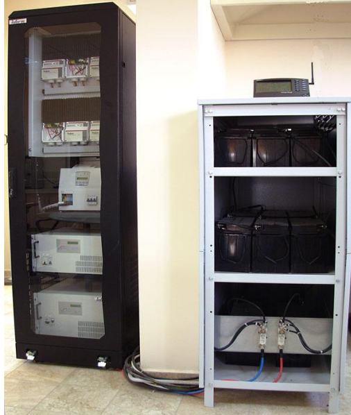
Şekil 5.6 Şarj Regülatörleri, Şarj Cihazı, İnvörtör Kabini ve Akü Kabini
