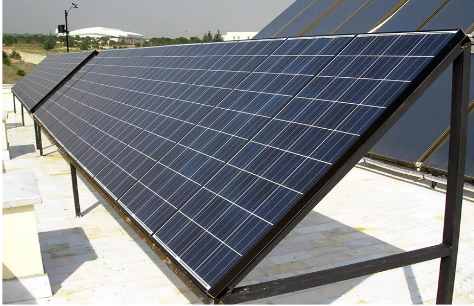
Şekil 5.2 Sabit eğimli olarak Temiz Enerji Evi'nin çatısına yerleştirilen güneş panelleri
