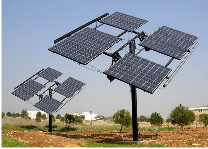
Şekil 5.5 İzleyici Üzerine Yerleştirilen Hareketli Güneş Panelleri
