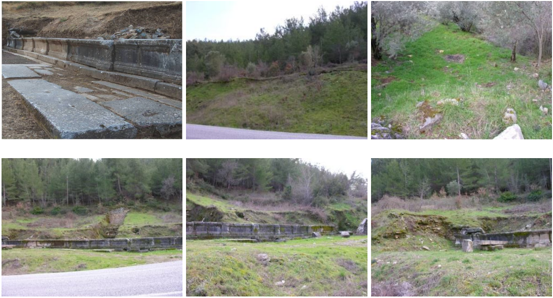
Şekil 2.9 : Su Yapısı ve çevresinin genel görünümü (8. istasyon)
