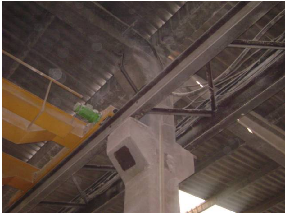
Şekil 3.4 Prefabrik yapı elemanına ait detay
