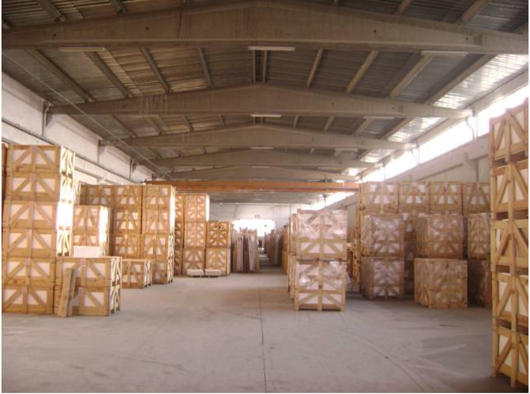
Şekil 3.3 Sahadan çekilmiş prefabrik yapının kullanım amacını gösteren fotoğraf
