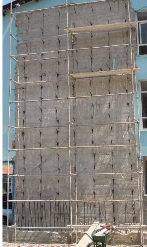
Şekil 1.2 : Bir ankraj uygulaması örneği (dış perde)
