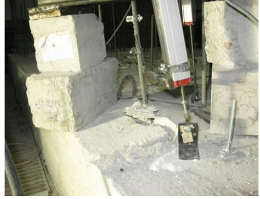
Betonun yarılmaması f12c12
