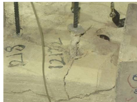
Betonun yarılması f12c12
