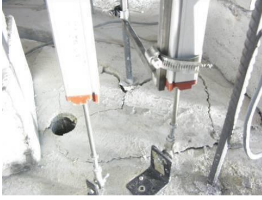
Betonun yarılmaması f12c12
