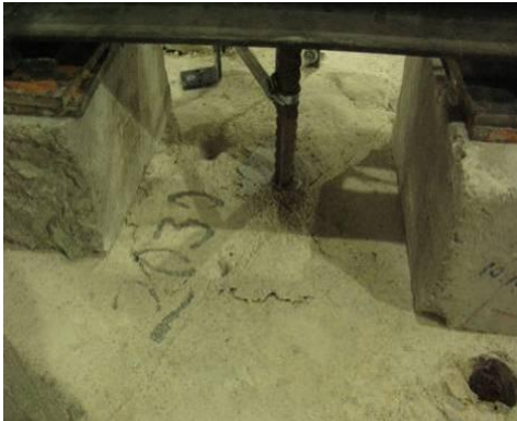
Betonun yarılması ve konik kopma f20c30
