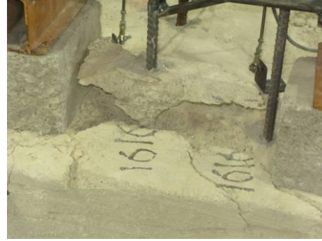
Betonun yarılmamas ve konik kopma f16c16
