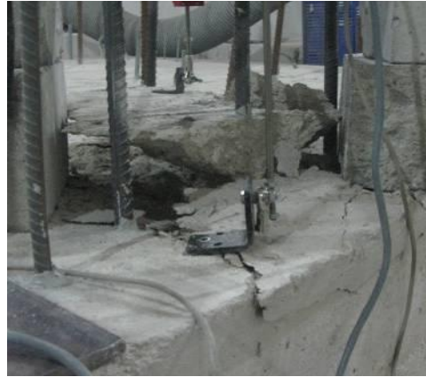
Betonun yarılması f16c16
