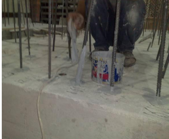
Şekil 4.9 : Ankraj deliklerinin temizlenmesi ve ankraj ekilmesi
