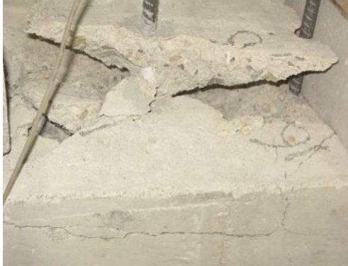
Konik kopma ve betonun yarılması f16c16
