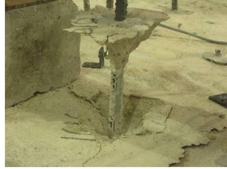
Betonun yarılmamas ve sıyrılmamas f16c16
