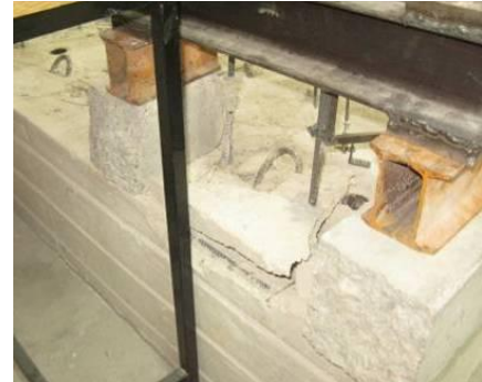
Betonun yarılması f12c12
