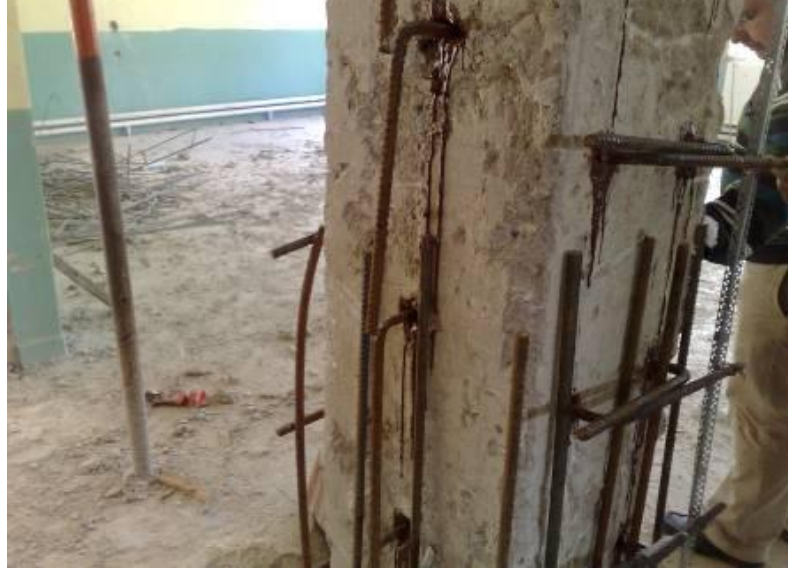
Şekil 1.1 : Bir ankraj uygulaması örneği (mantolama)
