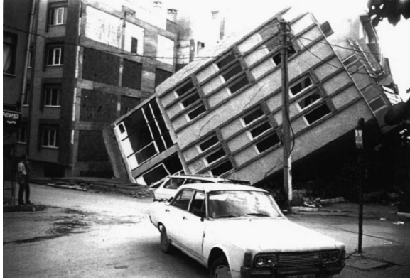
c) Sıvılaşma sonucu yan devrilmiş bina (Mollamahmutoglu vd 2003).
