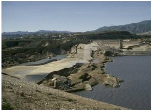
e) Barajlarda yenilme (Aşağı San Fernando Barajı, 1971)
