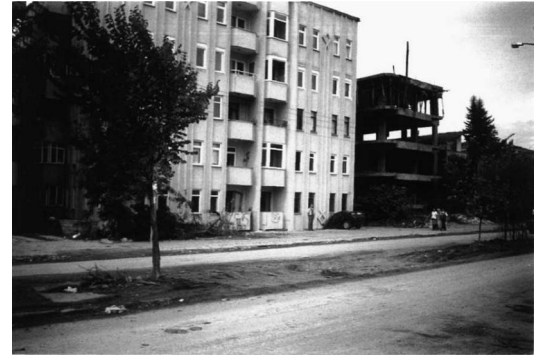
d) Sıvılaşma sonucu oturma meydana gelmiş, ikinci katı birinci kat seviyesine gelmiş, bina (Mollamahmutoglu vd 2003).
