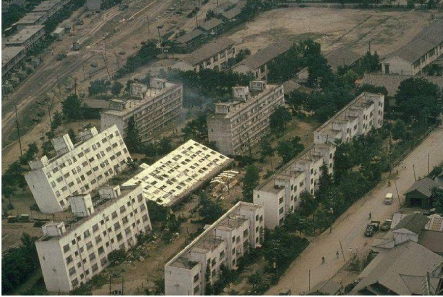
Şekil 2.1 1964 Niigata depreminde zemin sıvılaşmasına bağlı olarak binaların oturması ve devrilmesi (Steinbrugge Collection, EERC, University of California, Berkeley)
