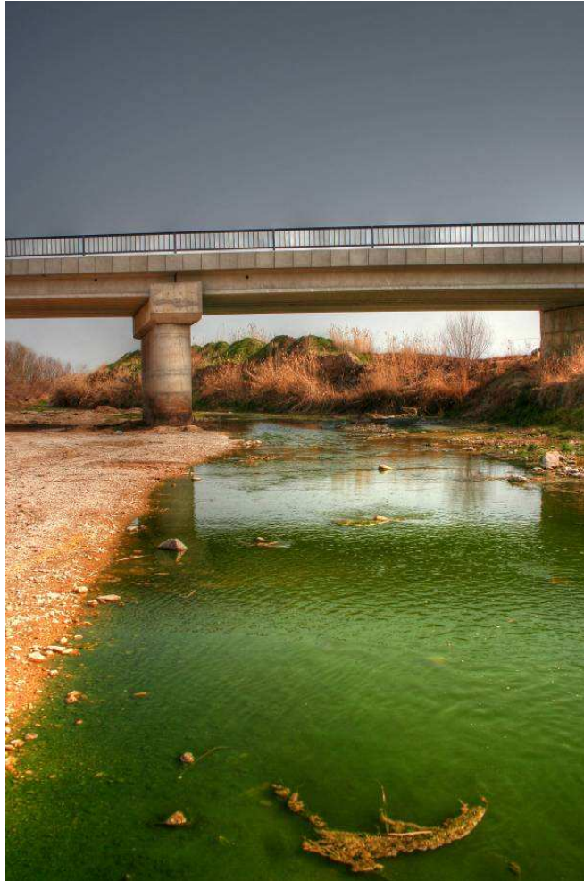
Şekil 2. 15: Ahmetli istasyonu. Sular çekilmiş olduğu zamana ait bir görünüm.
