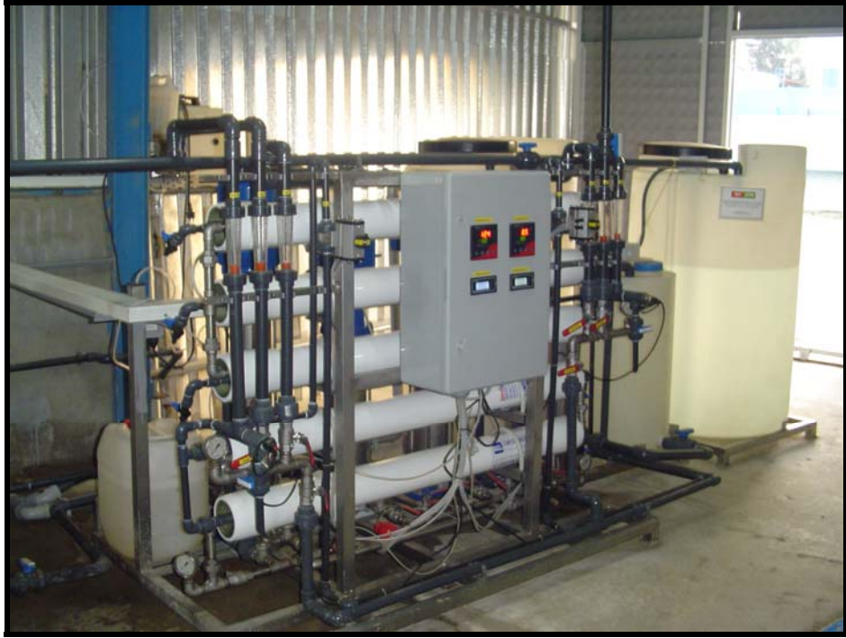
Şekil 7.9: Entegre ileri arıtma sistemi-nanofiltrasyon ve reverse osmoz üniteleri
