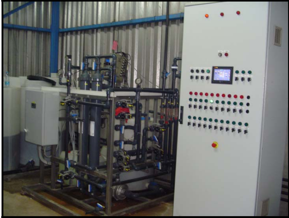
Şekil 7.8: Entegre ileri arıtma sistemi-ultrafiltrasyon ünitesi
