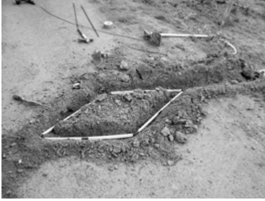
Şekil 2.6 Loop'un zeminin altına yerleştirilmesi
