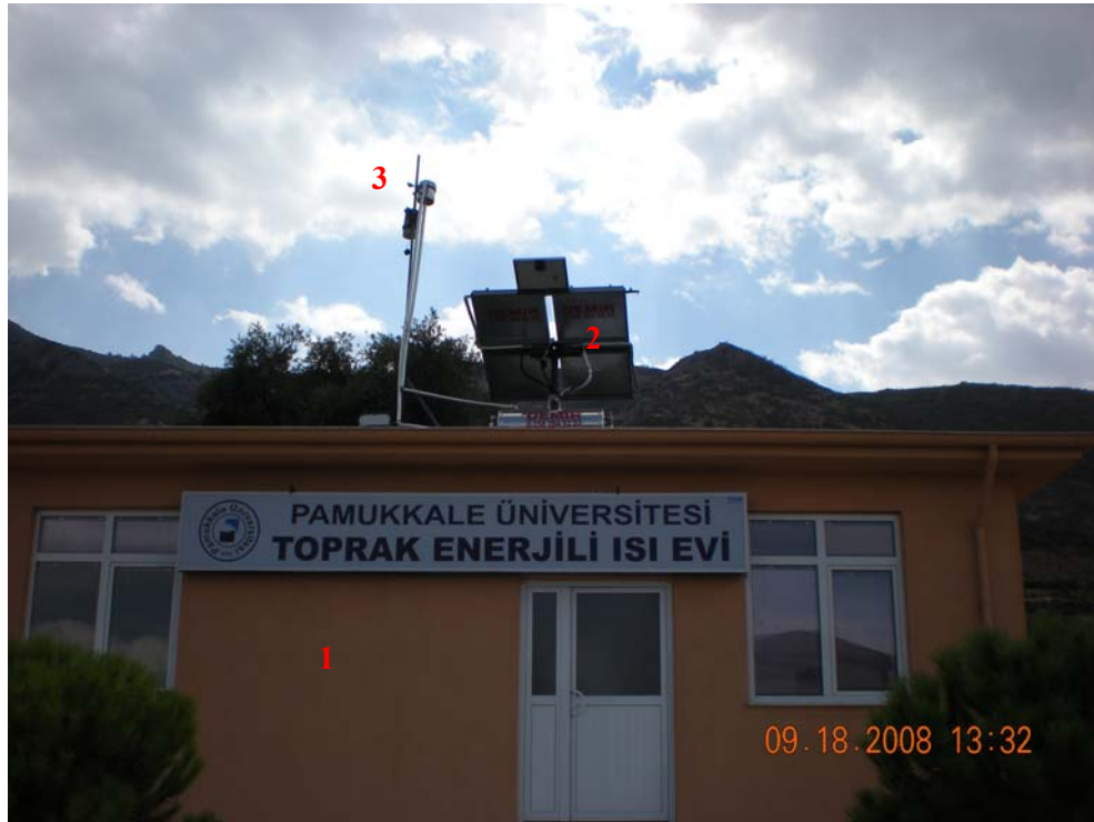
Şekil 5.1. Toprak enerjili ısı evi (1), güneş enerjisi sıcak su sistemi (2) ve meteoroloji istasyonu (3).
