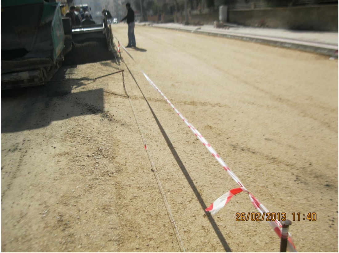
Şekil 3.4 Plentmiks Serilmesi
