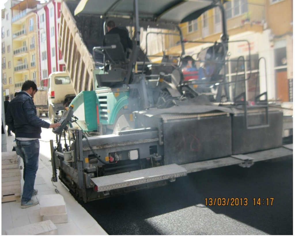
Şekil 3.9 Asfalt Aşınma Tabakası Yapılması
