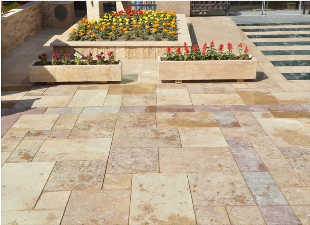
Şekil 3.7 Traverten Mermer Uygulaması
