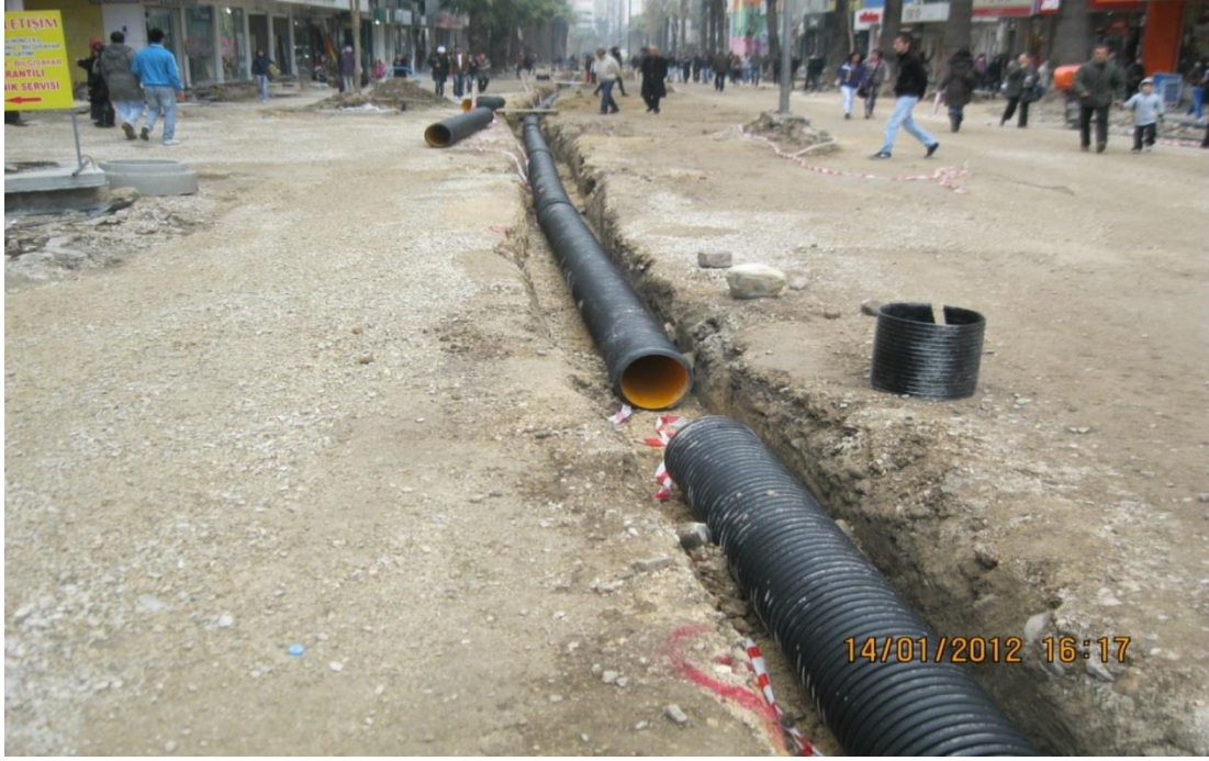
Şekil 3.3 Korige Boruların Döşenmesi
