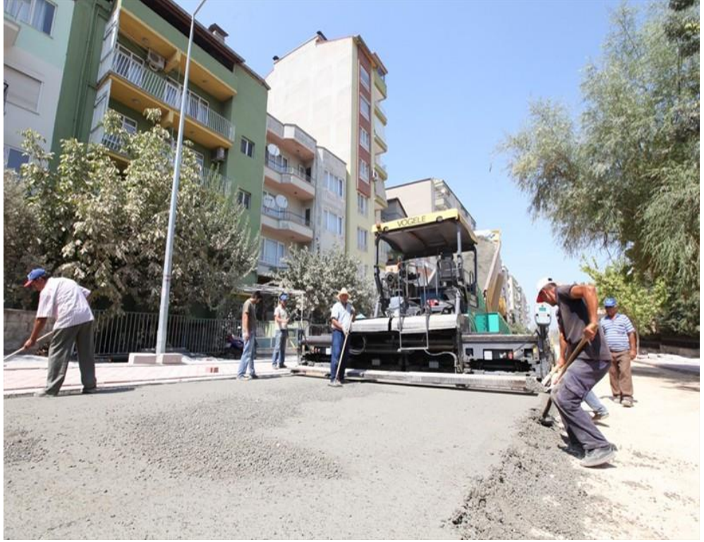
Şekil 3.5 RCC Beton Serilmesi
