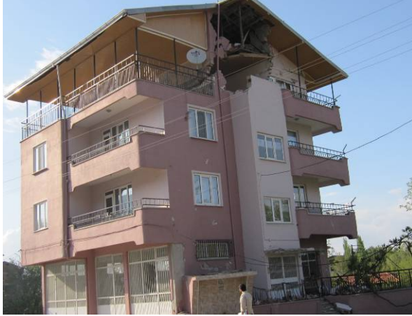
Resim 3.17 Çerçeve içerisine alınmamış ve hasar almış kalkan duvar örnekleri
