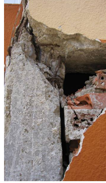
Resim 3.11: 19 Mayıs 2011 Simav depremi sonrası dolgu duvar davranışı nedeniyle oluşan kolon hasarları
