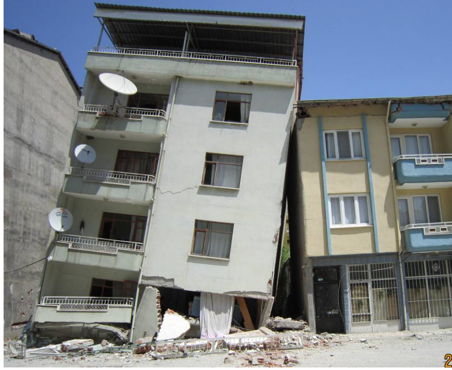
Resim:3.1 Simav depremi sonrası zemin katı tamamen göçmüş betonarme bina
