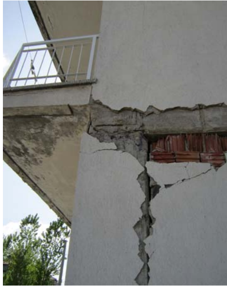
Resim 3.11: 19 Mayıs 2011 Simav depremi sonrası dolgu duvar davranışı nedeniyle oluşan kolon hasarları
