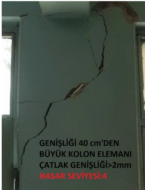
Resim 6.1: Kolon elemanlarda örnek hasar puanlamaları
