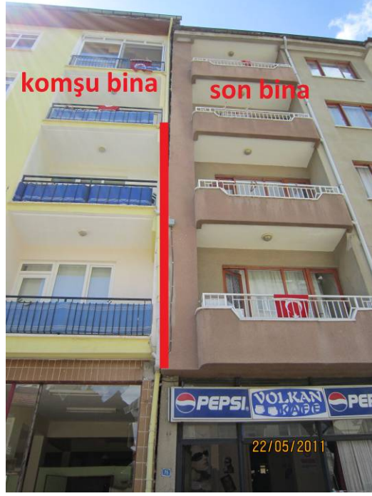
Resim 3.3: Simav Depremi sonrası düşey ekseninden kalıcı olarak kaymış betonarme bina
