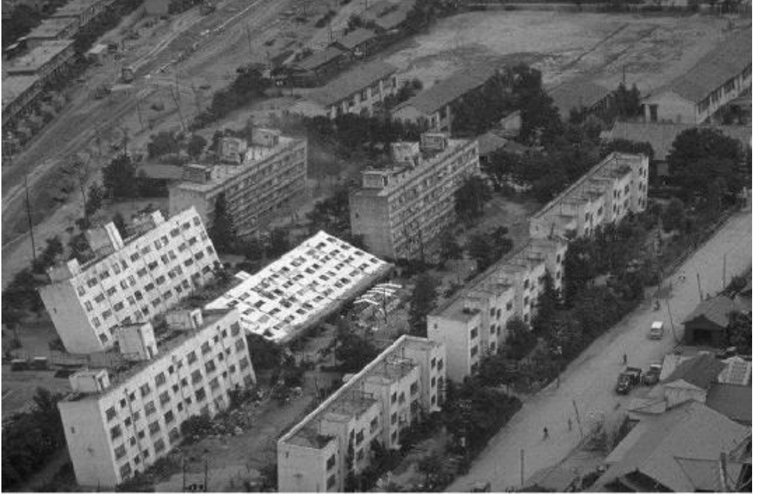
Şekil 6.1: 1964 Niigata depreminde zemin sıvılaşmasına bağlı olarak binaların oturması ve devrilmesi (Steinbrugge Collection, Earthquake Engineering Research Center, University of California, Berkeley).
