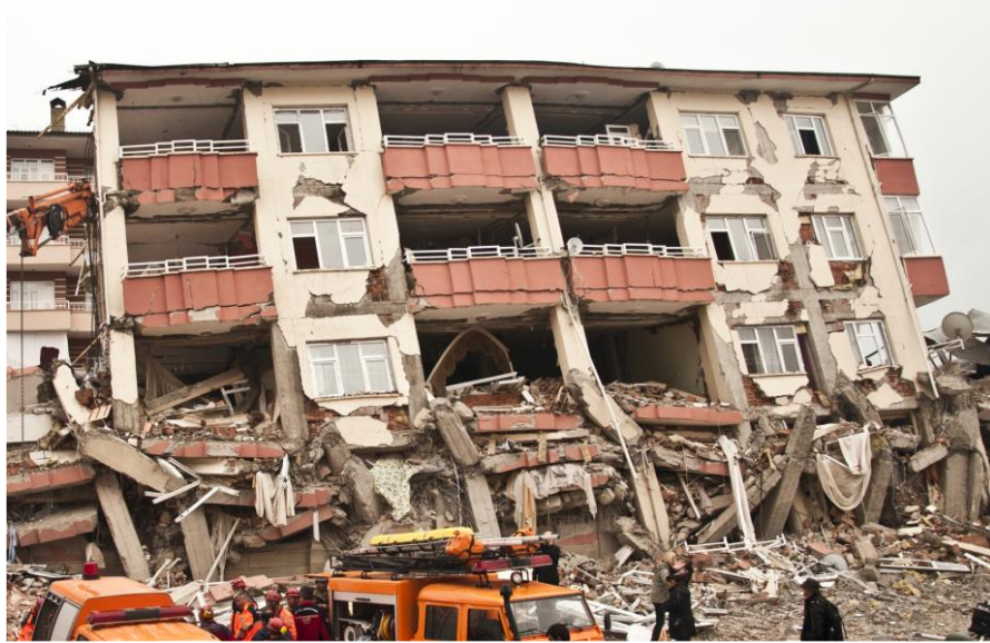
Şekil 3.16 2012 Van depreminde kat mekanizması sonucu yıkılan bir bina
