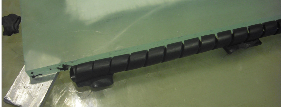
řekil 5.6 : Reine hattı (spiral) yerleřtirilmesi
