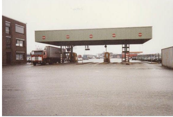
Şekil 3.11: Konteyner Terminali Giriş/Çıkış Kapısı
