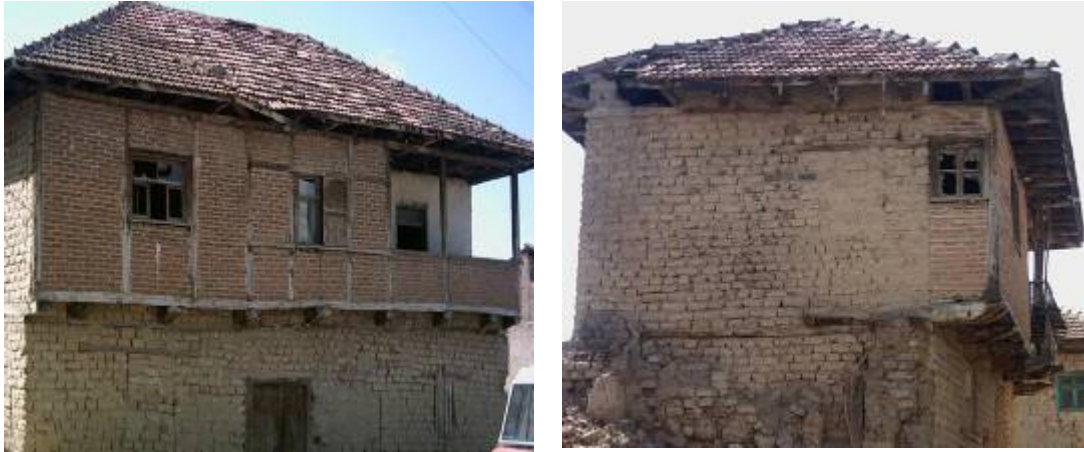
Şekil 4.29 Karahallı’da taşıyıcı duvar düşey süreksizliğine örnekler
