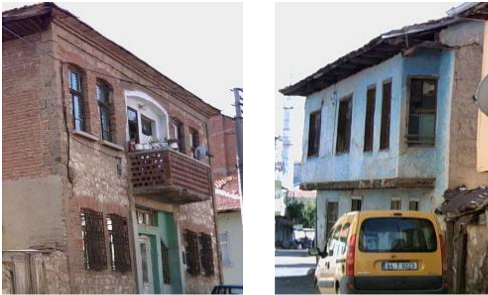
Şekil 4.39 Yapı boşluklarının bina köşesine uzaklığının sağlanamaması
