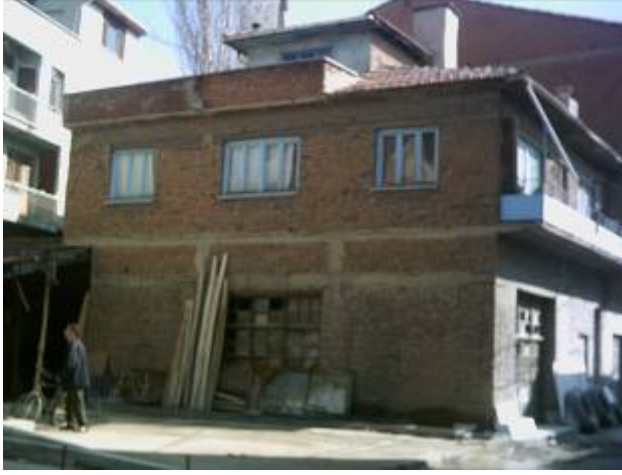
Şekil 4.27 Uşak'ta zemin kat yüksekliği 3,50 mt olan bir yığma yapı
