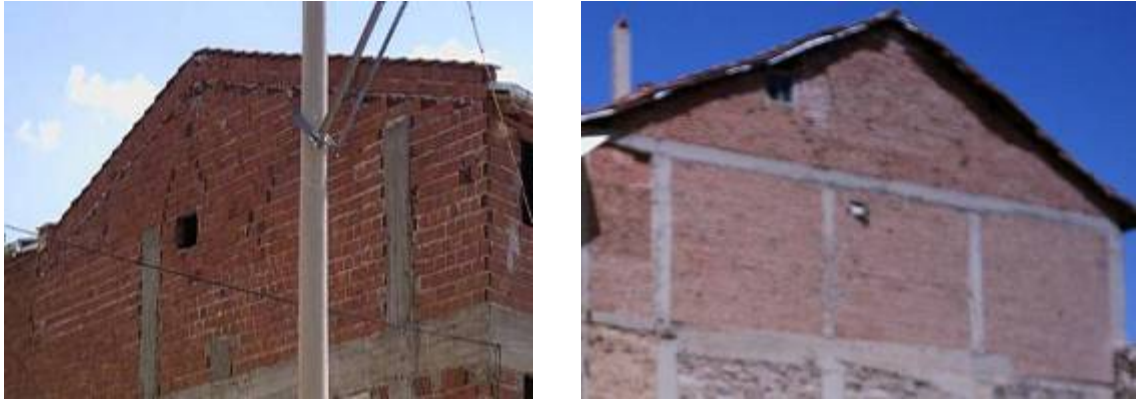
Şekil 4.18 Çeşitli kalkan duvar uygulamaları
