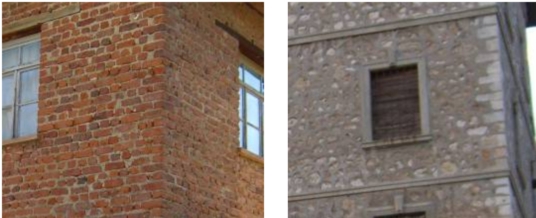
Şekil 4.22 Doğru köşe birleşimine örnekler
