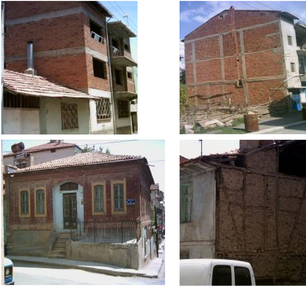
Şekil 4.7 Çeşitli yığma taşıyıcı sistem yapı tipleri
