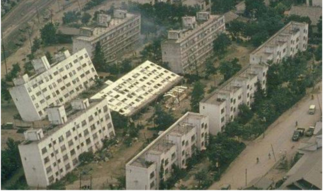
Şekil 4.1: Niigata depremi sonrası sıvılaşma etkisiyle zarar gören yapılar (Japan National Committee on Earthquake Engineering 1965).
