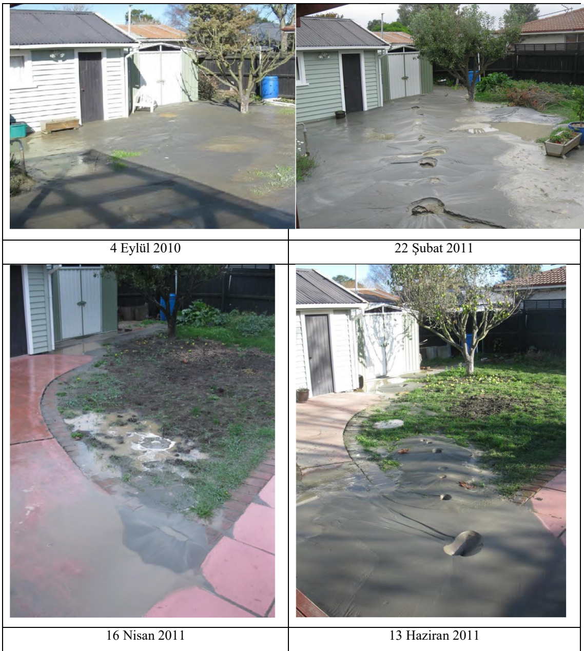
Şekil 2.2: Tekrarlı sıvılaşmanın aynı yerde farklı depremlere göre etkisi (Quigley ve diğ. 2013)
