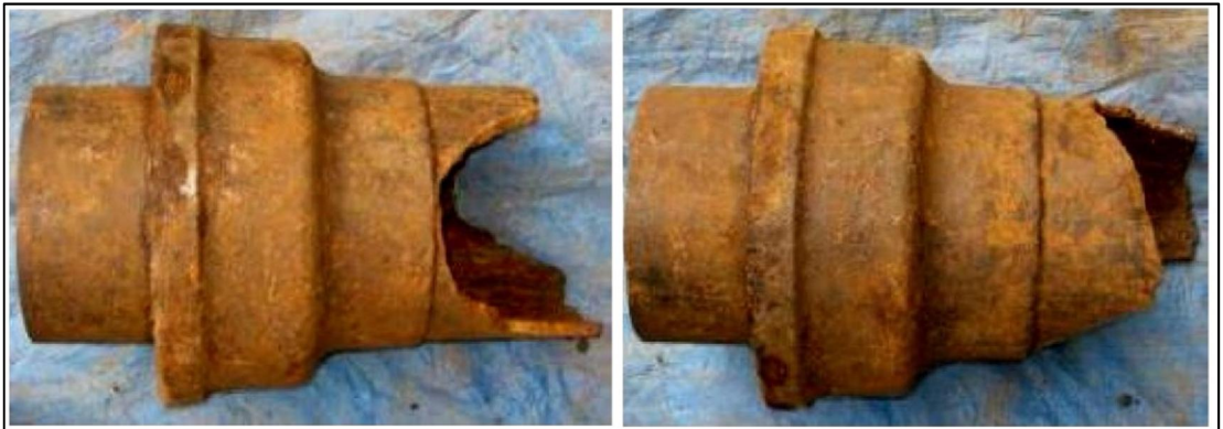
d) Dökme Demir Boruda Kırılma (temizlendikten sonraki durumu)
