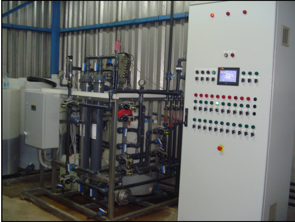
Şekil 3.5: Ultra filtrasyon ünitesi
