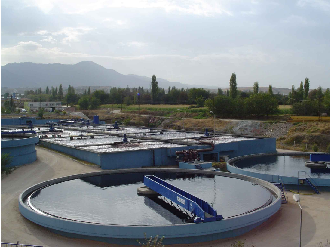
Şekil 3.1: Arıtma tesisi genel görünümü
