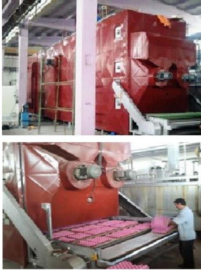
Şekil 2.1 : Sanayi ortamındaki yumurta kolisi kurutma sistemi.
