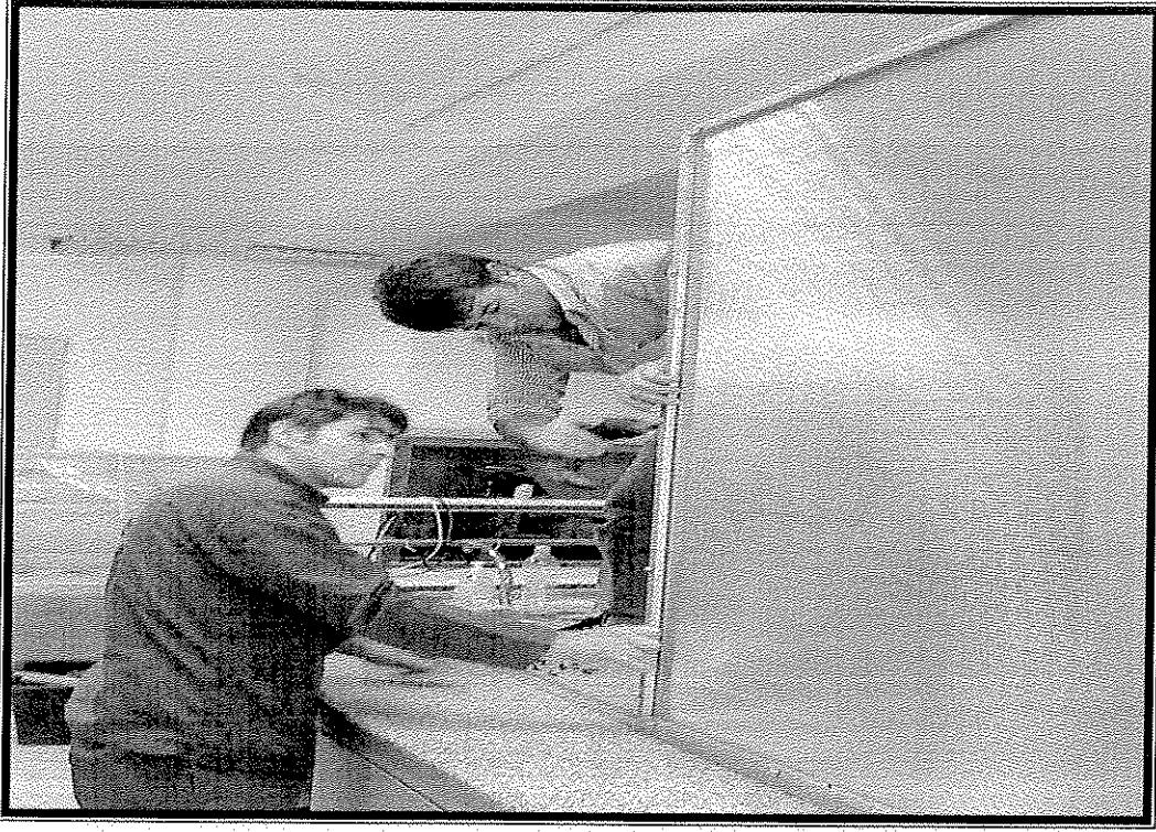
Şekil 3.3: Polikarbon perdenin iskelete tutturulması
