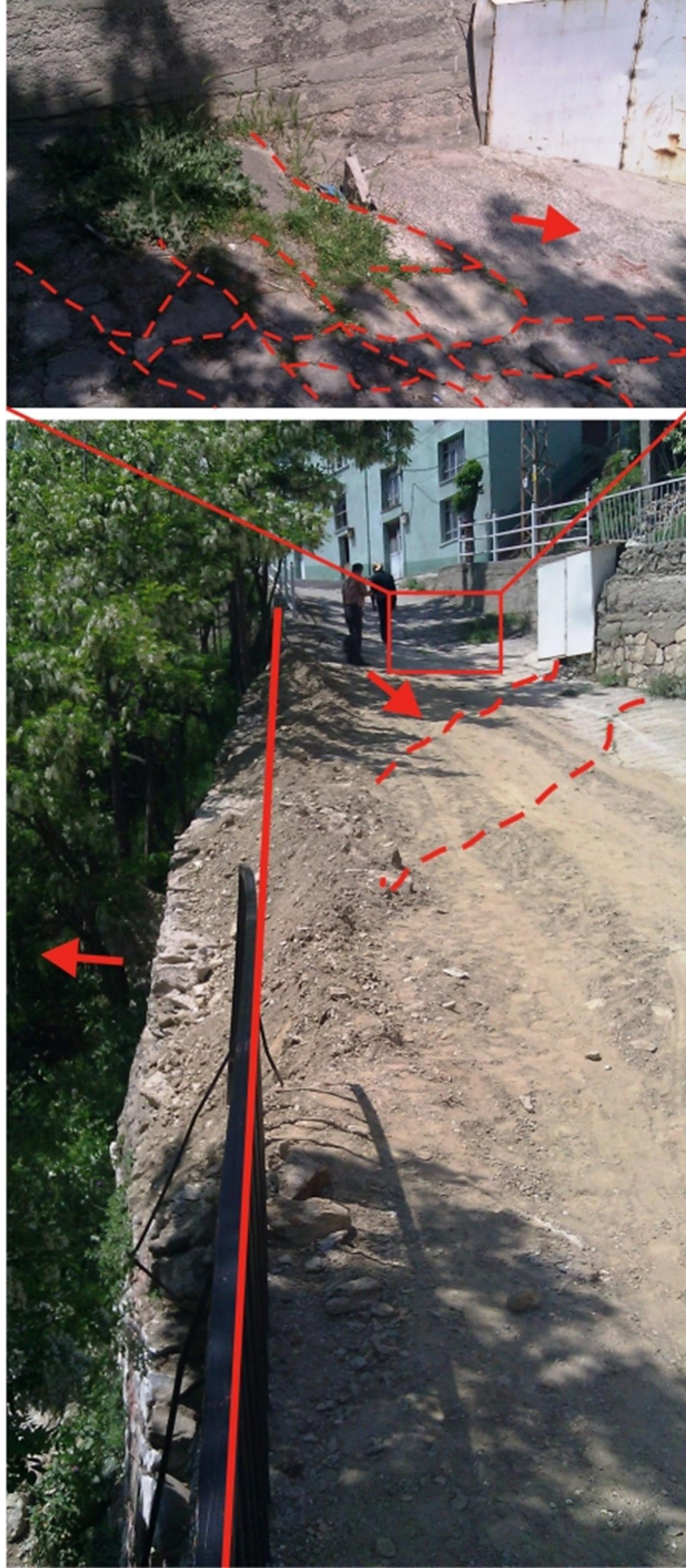
Şekil 5.18 : AE-4 istasyonunun alt ve üst kesimlerinde gözlenen deformasyonlar.
