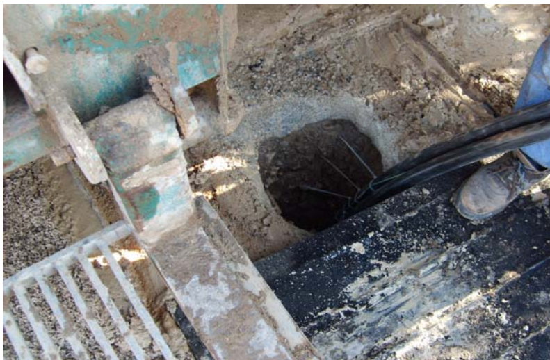
Şekil 4.15 Kuyu aęzından toprak ısı deęiřtiricisi borusunun sondaj kuyusuna yerleřtirilmesine ait grnt.
