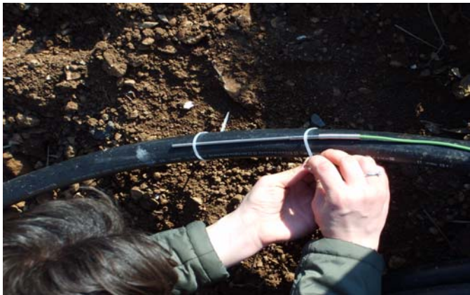
Şekil 4.13 Sıcaklık ölçerin boru üzerine yerleřtirilmesi.
