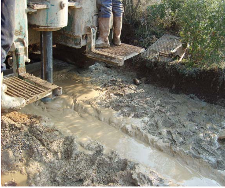
Őekil 4.6 Sondaj kuyusunun açılması.
