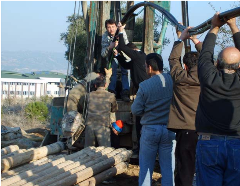
Şekil 4.14 Toprak ısı deęiřtiricisi borusunun sondaj kuyusuna yerleřtirilmesi.
