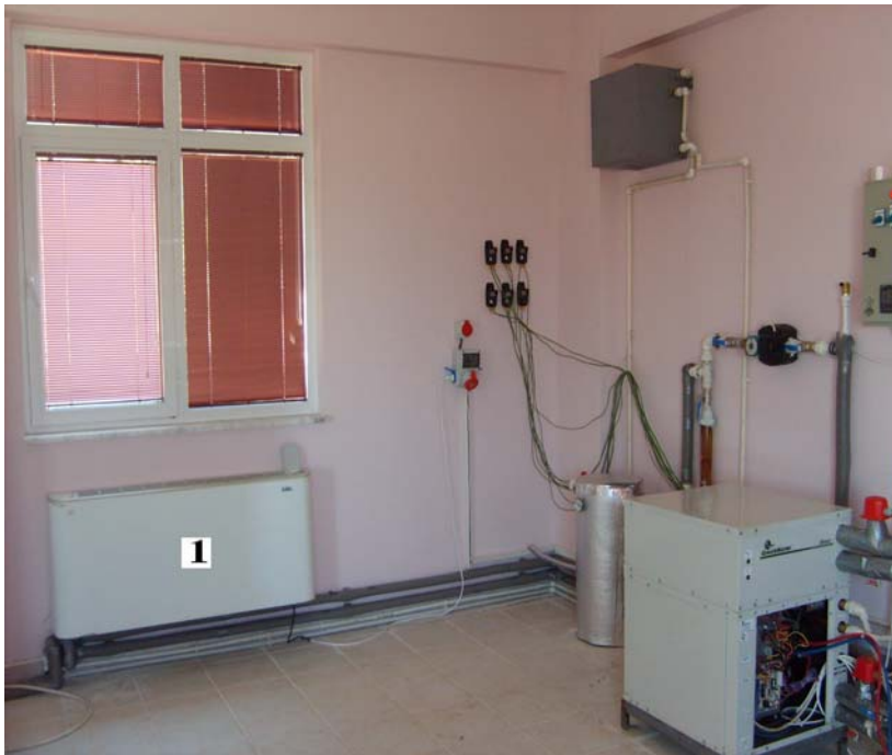
Şekil 4.19 Toprak destekli ısı pompası cihazı ve fan-coil sistemi.
