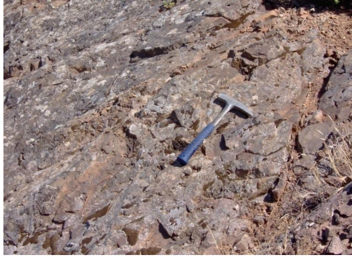
Şekil 4.12 Çal birimi içerisinde bulunan kırmızımsı-mor renkli spilitik kayalardan bir görünüm.
