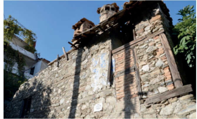
Resim 5. Yuvarlak ve dikdörtgen kesitli baca örnekleri (Kasım 2014).
