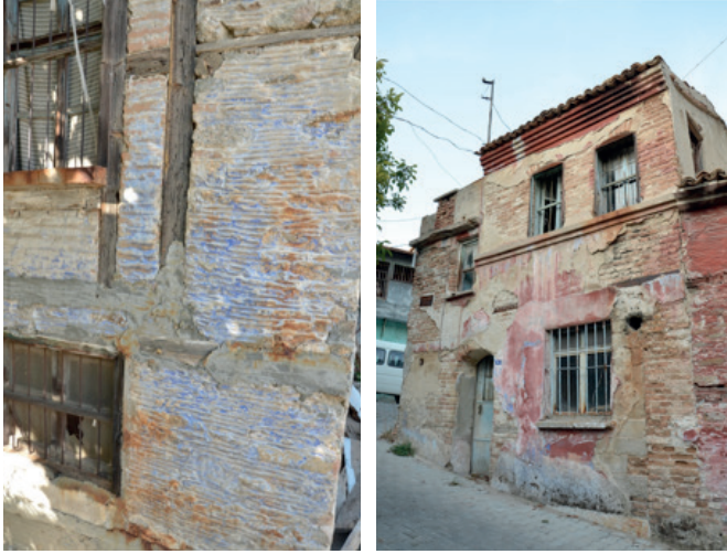
Resim 2. Çamur sıva uygulaması (Ekim 2014).
