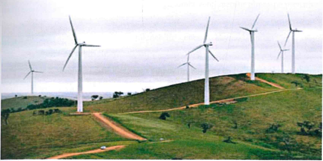
Şekil 2.7: Yatay Eksenli Bir Rüzgâr Türbini ve Rüzgâr Santrali
