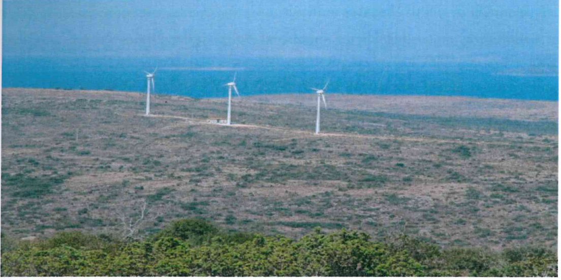
Şekil 2.5: İzmir – Çeşme, Alaçatı Mevkiinde Bulunan Türkiye'nin İlk Rüzgâr Santrali
