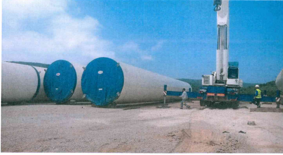
Şekil 4.12: Rüzgâr Türbini Kulesi (Yalova RES Şantiyesi)
