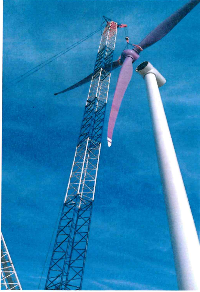
Şekil 4.8: Montaj Sırasında Kanatlar (Uşak RES)
