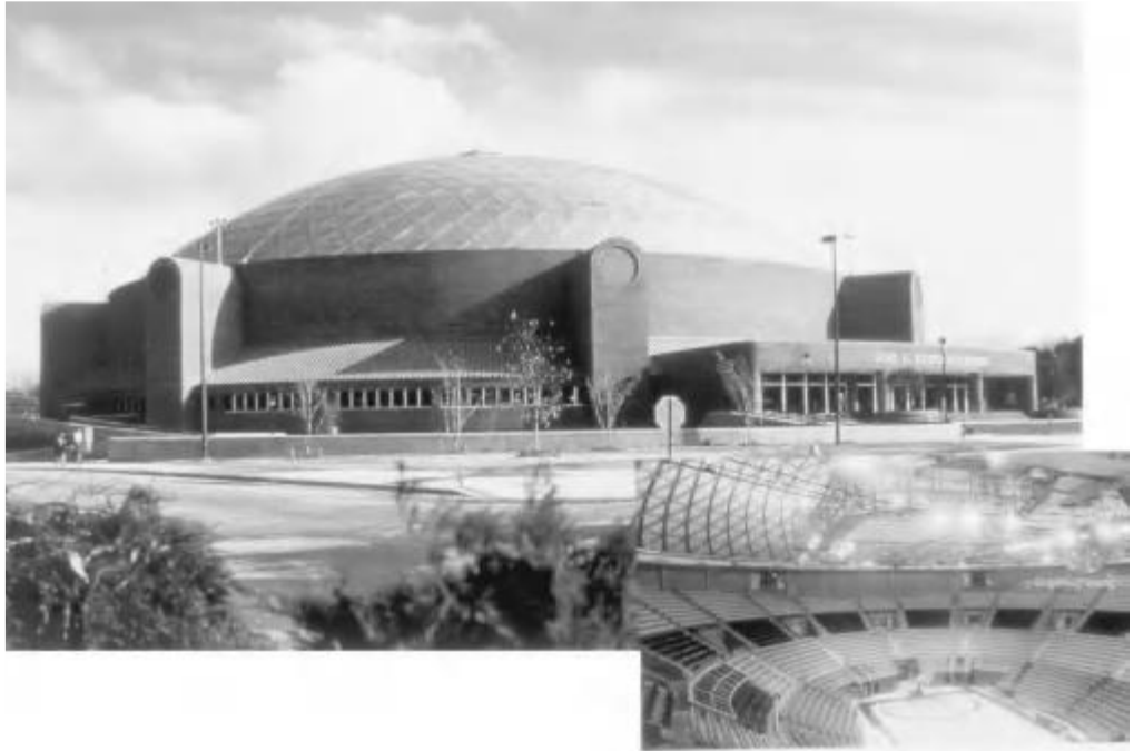
Şekil 2.7: Geniş arena çatılarında destek amacıyla kullanılmış AA6061 veya AA6063 alaşımlı alüminyum borular (Kaufman 2006)
